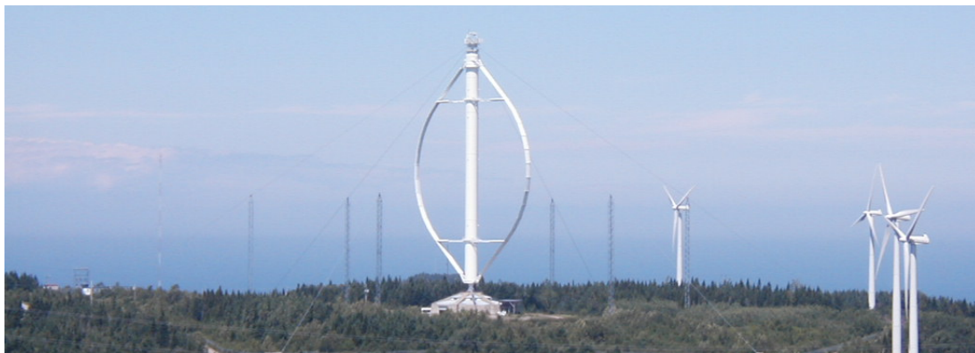
FIGURE 1.5 – Une éolienne Darrieus expérimentale du parc éole à Cap Chat, Quebec
