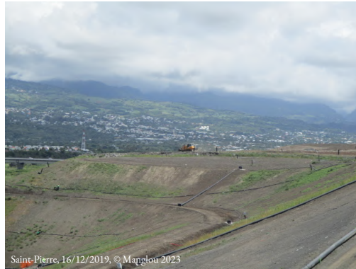
Tranche fermée. Les déchets sont recouverts de géotextile puis de terre, et irrigués par des tuyaux de captation des lixiviats et des gaz.
