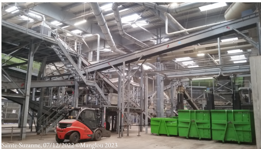
FIGURE 4.43. – Photographie du centre INOVEST à la veille de la livraison de l'unité de production de Combustible Solide de Récupération (CSR) (2022)
