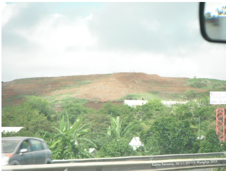
FIGURE 4.2. – Photographie du centre d'enfouissement de Sainte-Suzanne, La Réunion, depuis la route nationale (2019)
