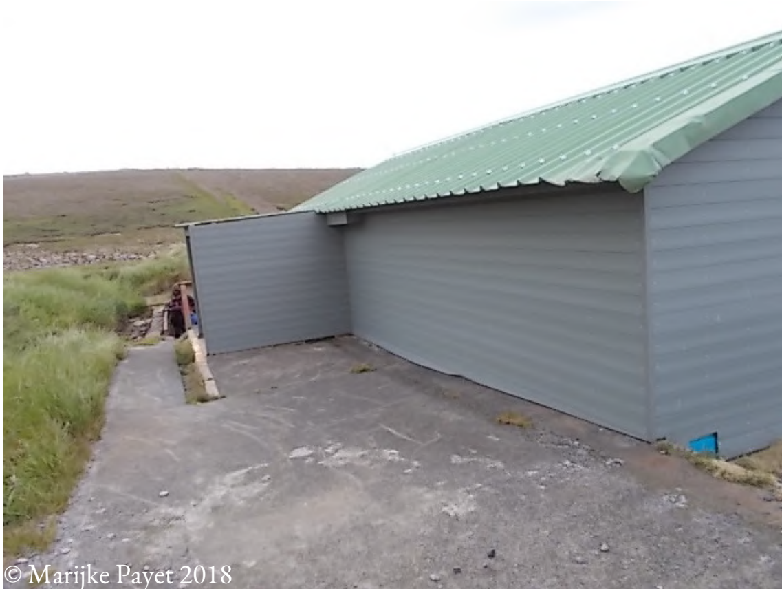
FIGURE 7.3. – Photographie d'un abattoir dans les Terres Australes et Antarctiques Françaises, réalisé à partir de briques de plastiques fabriquées à La Réunion (2018)
