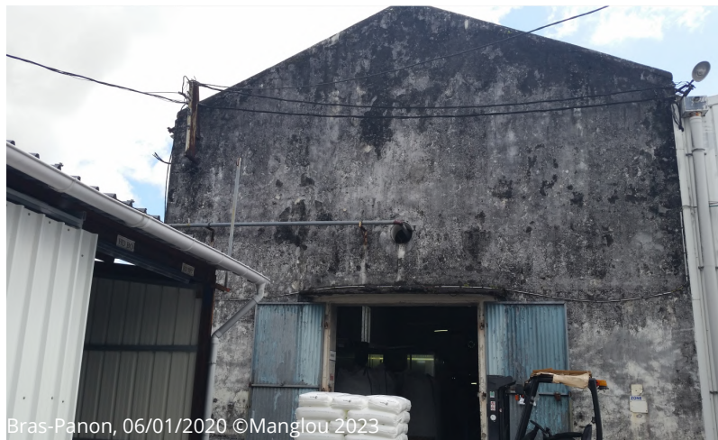
FIGURE 6.10. – Photographie des locaux de Bourbon Plastiques, dans une usine à sucre désaffectée, Bras-Panon, La Réunion (2020)
