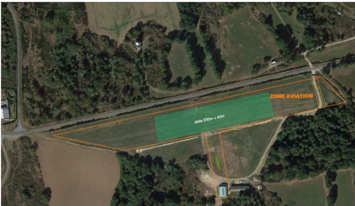
FIGURE A.4 – Zone Aviation implantée sur les parcelles A969, A970, A971, A972 et ZD8 de la station expérimentale de Monterfil. La Zone Aviation comprend une aire d'atterrissage et de décollage avec ses dégagements, un taxiway ainsi qu'un bâtiment (hangar) dédié aux activités aéronautiques.
