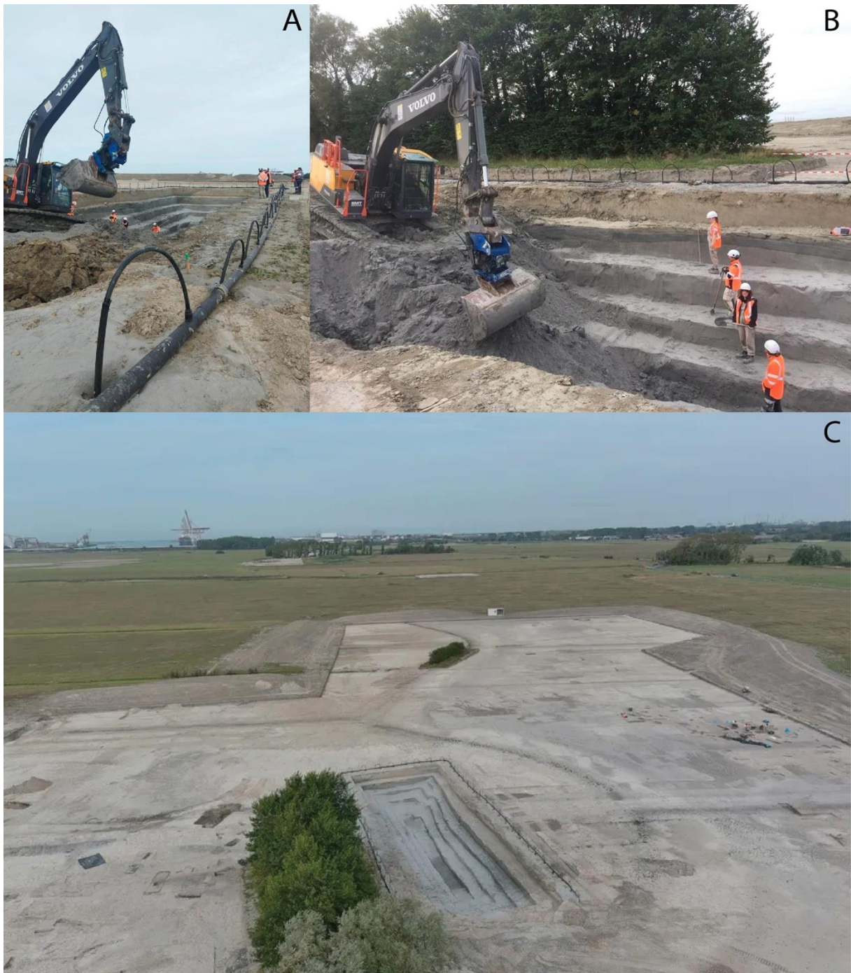
Figure V-30 : Fouille en pyramide inversée réalisé en octobre 2023. A : Dispositif de pompage pour rabattre la nappe phréatique (M. Tyrrell, Inrap). B : Creusement à la pelle mécanique. Les palliers ne forment pas des niveaux archéologiques détaillés séparément mais permettent de descendre la fosse plus profondément sans risque les effondrements (V. Charpentier, Inrap). C : Vue aérienne (drone) de la fosse entièrement creusée (M.Ocadiz, Inrap).
