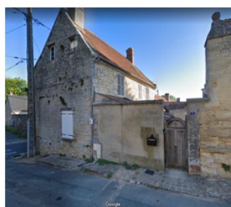
FIGURE 2.9 – À l’aide de la base DVF, il est visible que le bâtiment a été subdivisé. De plus, le dernier étage, l’attique n’est pas aménagé.
