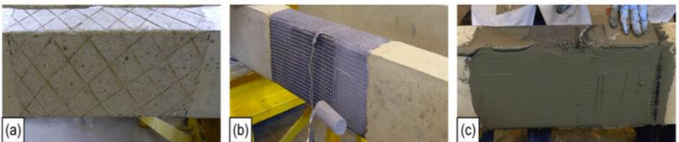
Figure I.45 : Méthode d'application du TRC sur la surface des poutres (a) préparation de la surface d'application avant le renforcement (b) une première couche de mortier est appliquée avant la mise en place du premier textile (c) une deuxième couche de mortier recouvre le textile (C. Tetta and A. Bournas, 2016)
