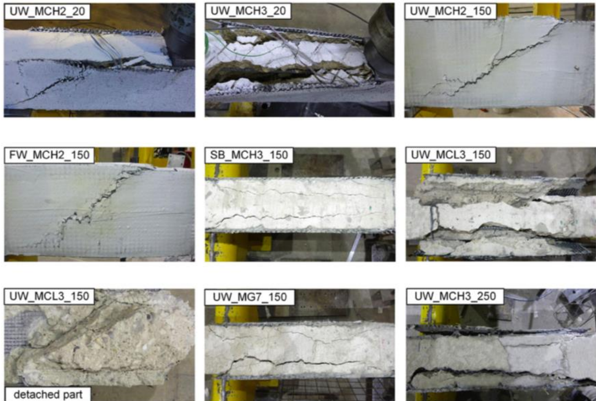
Figure I.46 : Modes de rupture des poutres en béton armé renforcées par des TRC vis-à-vis de l'effort tranchant (C. Tetta and A. Bourmas, 2016)
