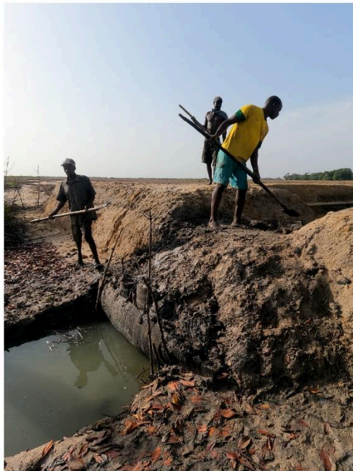
a. construction d'un bassin piscicole dans une ancienne vasière rizicole (Kaghiengat, 2022)
