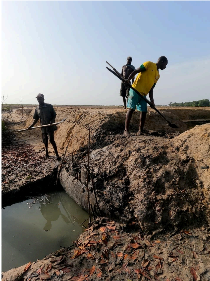
Figure 101. A Djivente, des hommes creusent un bassin piscicole au kayendo. Ils espèrent y élever du poisson pour pallier les importants besoins villageois, 2022.
