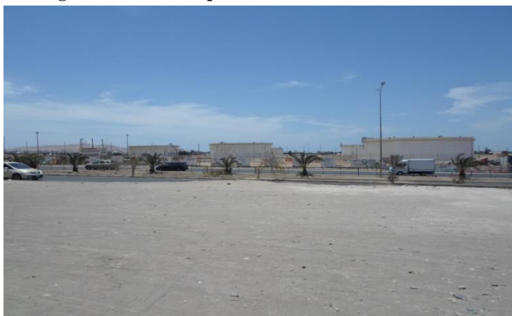
Figura 37. Los estanques bolivianos Sica Sica en Arica
