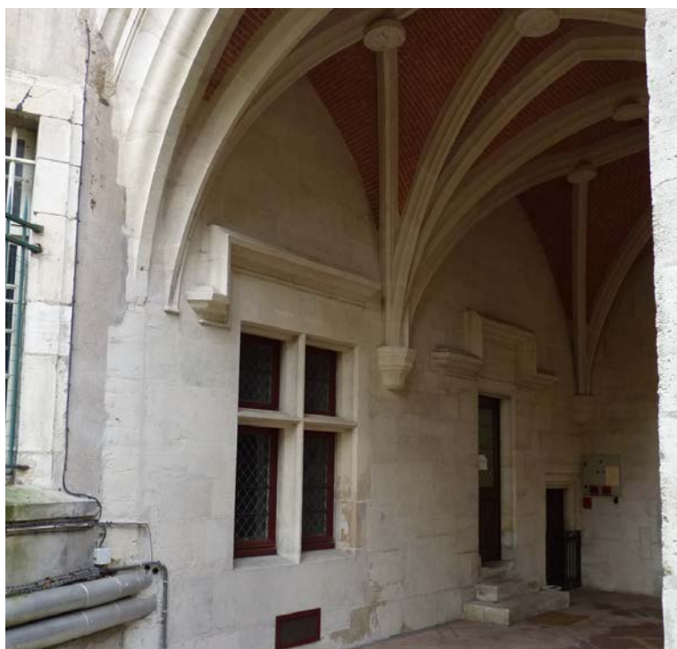
Fig. 75 : Derniers éléments de la façade sur cour de l'aile sud encore visibles sous le portail de la porterie
