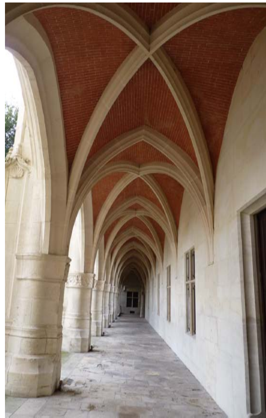
Fig. 66 : Portique à intrados peint de fausse briques, état actuel après restauration
