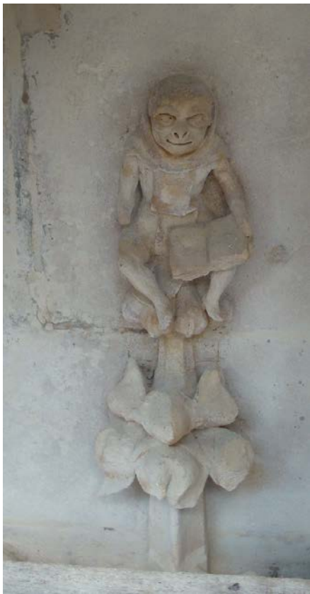
Fig. 65 : détail du sommet du fleuron au dessus de la porte piétonne
