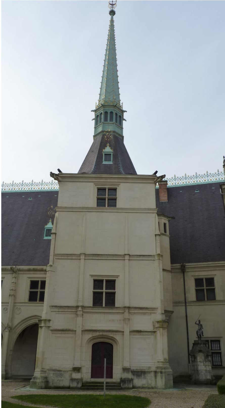
Fig. 74 : Tour de l'Horloge vue depuis l'est, état 2022
