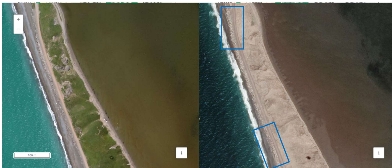
Photo 42 : Comparaison du même tronçon de l'isthme en 2005 et 2017 : la quantité d'enrochements a augmenté et de nouveaux endroits ont été enrochés. Source : Remonter le temps, IGN. Réalisation : X. Philippenko, 2023.
