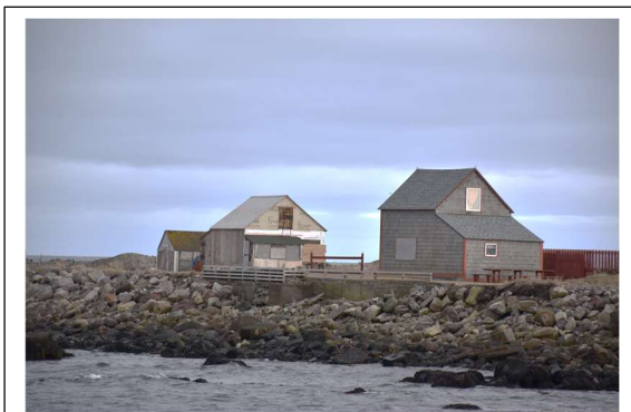
Photo 40 : Érosion et enrochements en front de mer devant deux maisons de l'anse à Bertrand (Saint-Pierre). Photographie : Xénia Philippenko, 2021.
