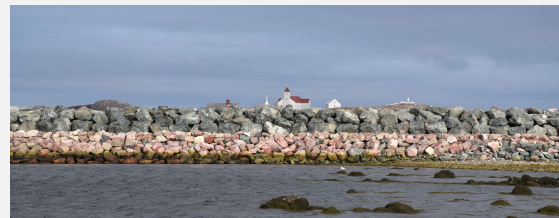
La digue aux Moules et les bâtiments de l'Île-aux-Marins. L'ancienne ligne d'enceintes est en pierre rose locale ; la nouvelle en pierre grise du Nouveau-Brunswick (Canada). Photo : Xénia Philippenko, 2021
