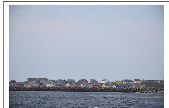
Photo 7 : Côte artificialisée, ville de Saint-Pierre. Source : X. Philippenko, 2019
