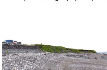
Lignes de gabions et rechargement de plage pour protéger le parking de Langlade
