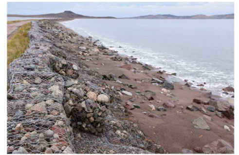
Protection du littoral par gabions sur la route de Mirande. Source : Xénia Philippenko, 2018
