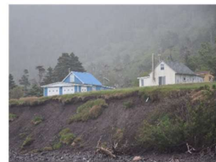
Maisons secondaires surnommées « châteaux », menacées par l'érosion des falaises morrainiques
