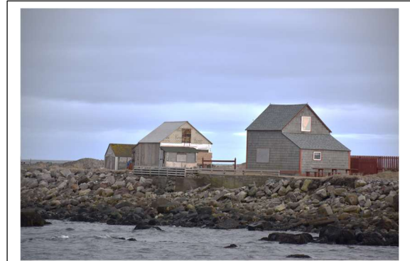
Photo 40 : Érosion et enrochements en front de mer devant deux maisons de l'anse à Bertrand (Saint-Pierre). Photographie : Xénia Philippenko, 2021.
