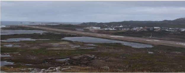
Site 2 : Aéroport de Saint-Pierre-et-Miquelon. Photographie : Xénia Philippenko, 2018
