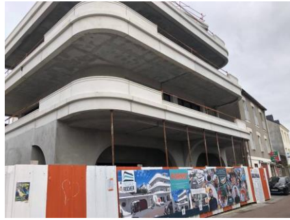
Fig. 64 : Le passage du Rocher en construction du côté de la rue de la Marine, en février 2023. Photo issue de l'article signé de Florence Lambert. (Journal Ouest France 05/02/2023).
