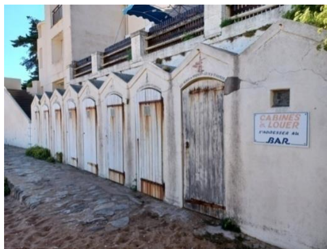
Fig. 30 : Les cabines de bains autrefois en location sont maintenant désaffectées et inutilisées. Photo personnelle, 2022.
