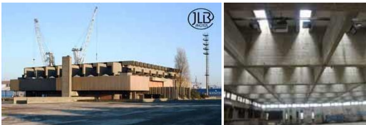
Fig. 129-130 : BCMO Dunkerque avant sa démolition. Photos JLB et pour le Hall intérieur, Journal La voie du Nord, 2004.
