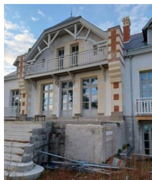
Fig. 21 : Ker Wisy en rénovation en 2020-23. Il ne s'agit pas d'une restauration à l'identique. Photo personnelle, 2023.
