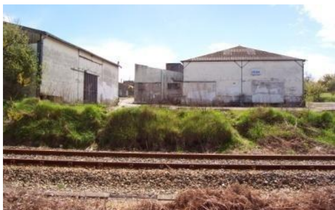
Fig. 131 : Sardinerie Paulet avant sa démolition en 2012. Photo Ville de Pornic, dossier de présentation de l'aménagement de la Ria.
