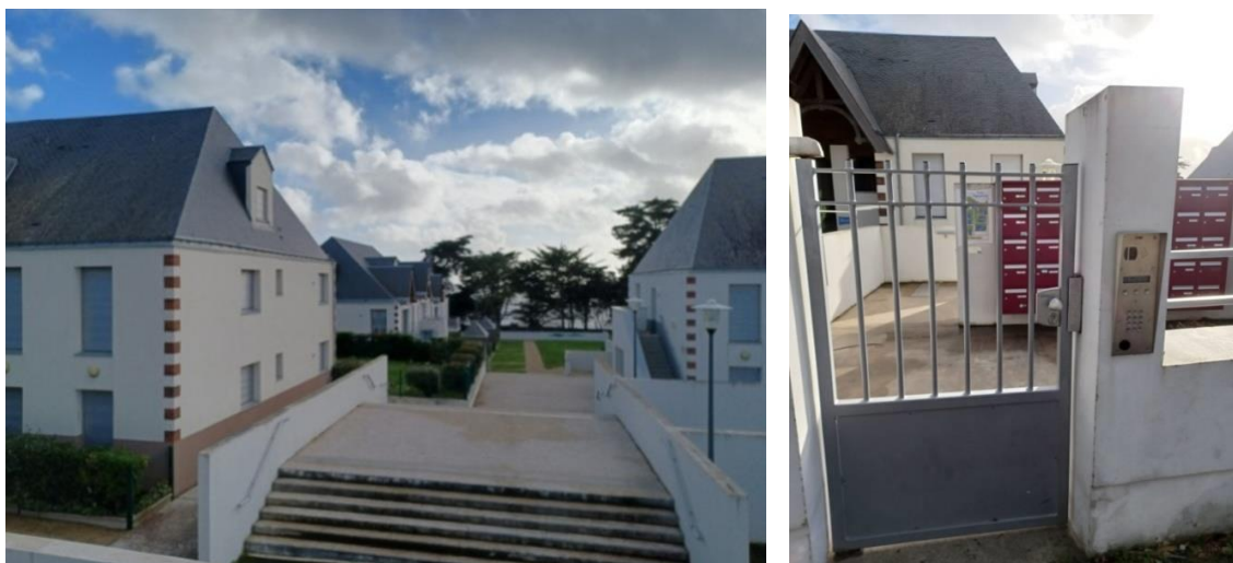
Fig. 119 : Résidence les Sylphes. Un ensemble clos et sécurisé. Photos personnelles. 2022.
