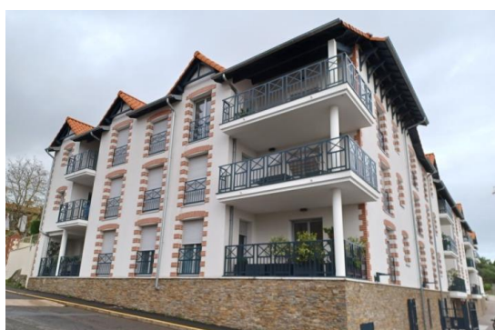
Fig. 10 : Immeuble place de l'église à Ste Marie. Photo personnelle, 2022.
