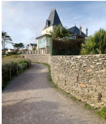
Fig. 39 : Pavillon Saint Gilles construit en 1895, dans le style néo-gothique, en bordure du sentier des douaniers accessible au 22 de la rue Neptune. Sa rénovation récente en a complètement modifié l'aspect, les murs du bow-window sont maintenant totalement ajourés de fenêtres. Photo personnelle, 2022. (Les attributions de style sont issues de la thèse d'Agathe Aoustin - 2013: Urbanisme et architecture balnéaire de la Côte de Jade, (1820-1975) repris sur le blog de Daniel Sicard ancien conservateur du patrimoine.)
