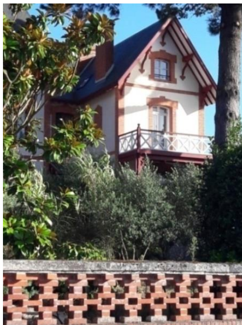
Fig. 35 : Roche Gann ou Villa Marguerite située sur la rue de la Corniche de Gourmalon construite en 1884 sur les plans de l'architecte Nantais François Aubry dans le style chalet. Photo personnelle. 2022.
