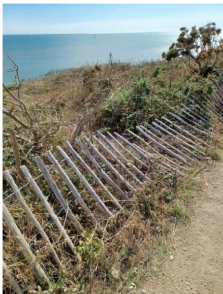
Fig 140 : En surplomb des criques, des chemins se frayent au travers des palissades en ganivelle de châtaigner. L'hostilité à la régulation des déplacements se fait sentir. Photo personnelle été 2023
