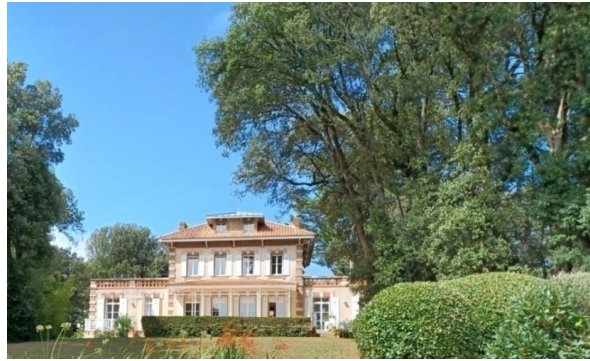
Fig. 38 : Villa El Biar construite 104 rue de la Source en 1877 sur les plans de l'architecte Léon-Félix Lenoir. « Une varangue d'inspiration créole. » (Aoustin 2013). Les deux ailes sont de construction récente. Photo personnelle, 2023.
