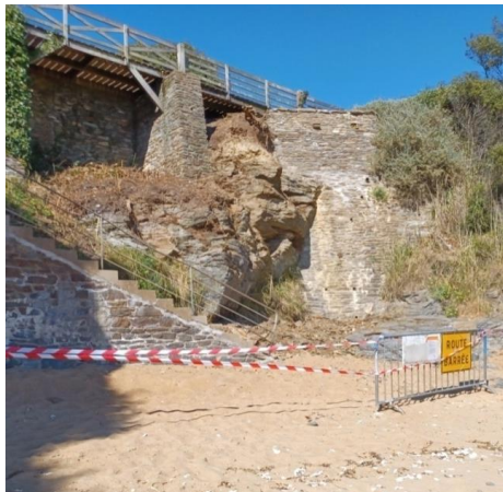
Fig. 94 : Éboulements sur le boulevard de l'Océan entre la plage de la Noëveillard et la plage des Sablons, ayant nécessité à l'été 2022 un arrêté municipal et la sécurisation du site. Photo personnelle, 2022.
