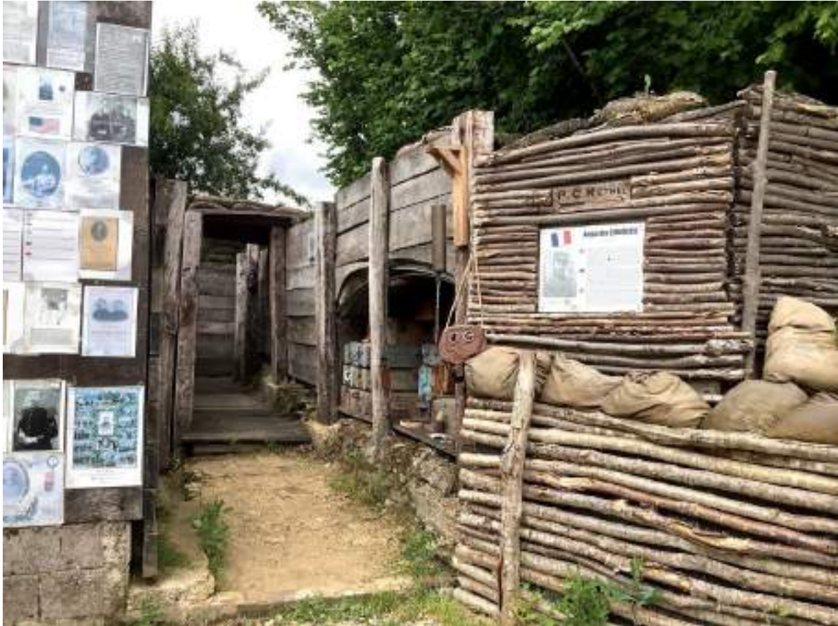
Vue de l'entrée de la tranchée
