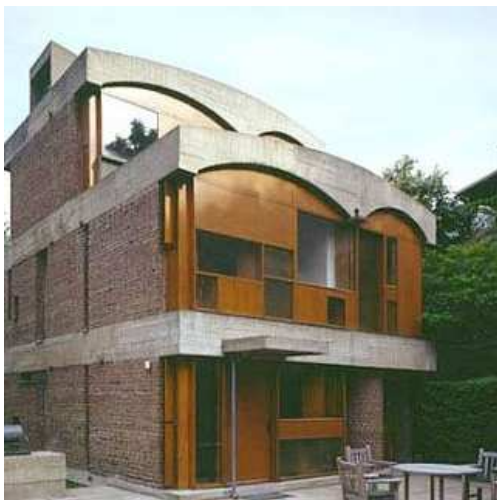
Fenêtres de la maison Jaoul.
