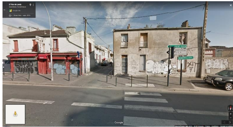
Photographie 2: Logements anciens de la rue du Landy. Source : Google Maps, consulté le 23.02.2018.
