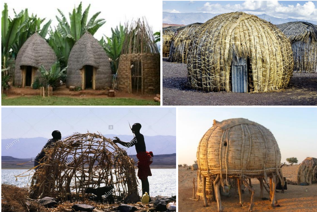
Figure 104 – Huttes du village Chench (peuple Dorzé) en construction (en haut à gauche) ([Kevin Smith], et huttes du lac Turkana (en haut à droite et en bas) [Eric Lafforgue, Bjorn Svensson, Alamy & Richardandmarthashaw.blogspot.com].
