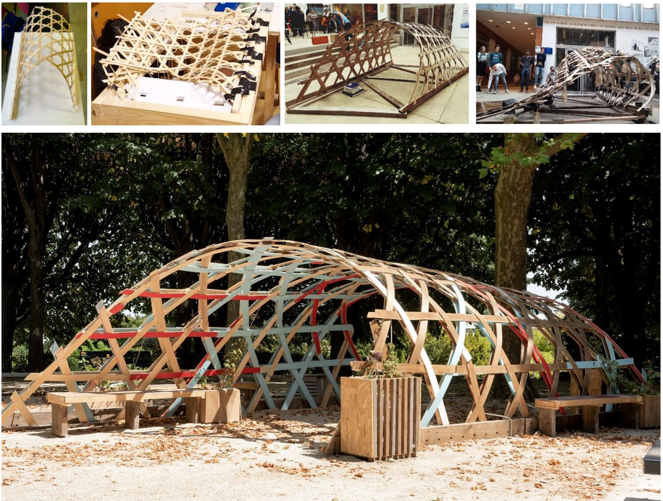
Figure 93 – Essais de chargement des modèle réduits à échelle 1/10ème et 1/2 et photographie du gridshell Kagome [crédits photo : David Cousin-Marsy]
