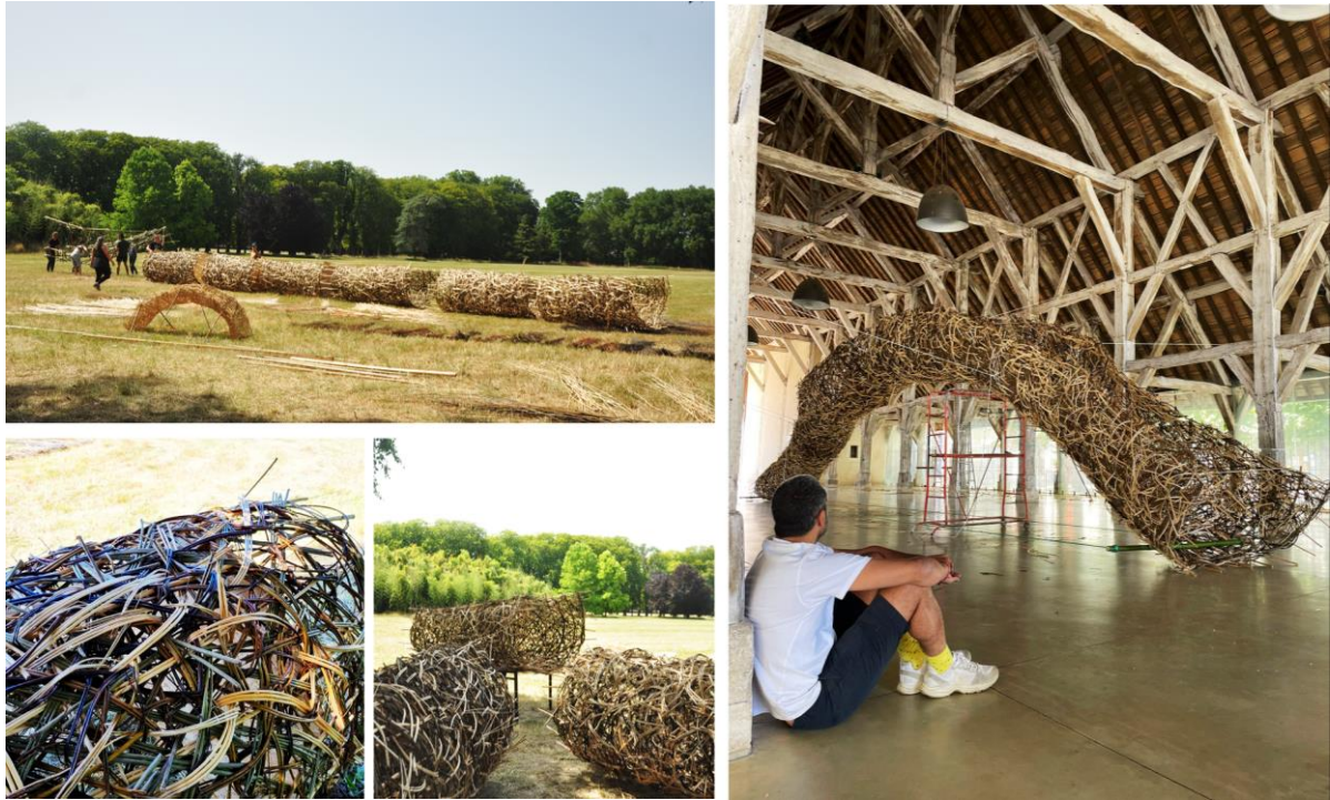
Figure 23 – Phasage de la construction et tressage préliminaire par l’algorithme BAYA de la passerelle en osier des Utopies Constructives [39] [3D par Nicolas Prévost, Photos par Inès Macia et Quentin Chef]
