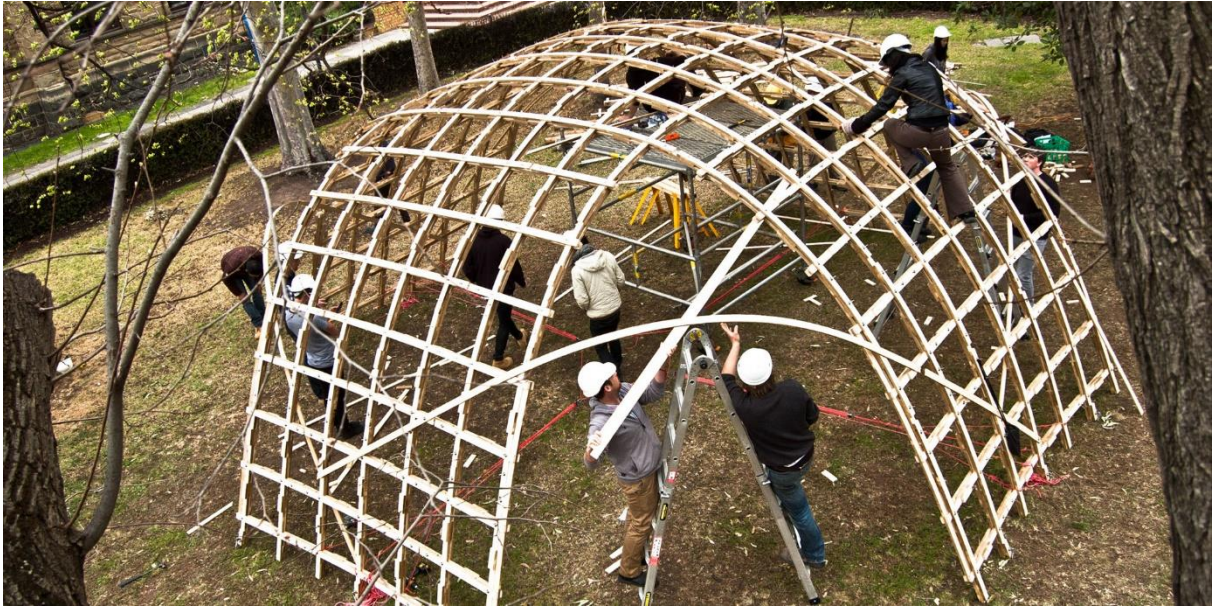
Figure 10 – Accoya post-formed gridshell par les étudiants de la Melbourne School of Design en Australie.
