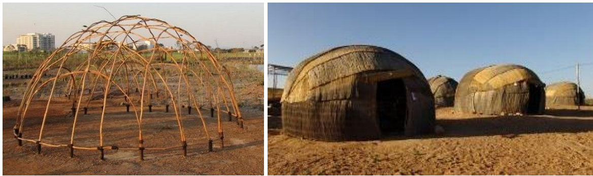
Figure 29 – Les différents étapes de construction des Haru Oms, huttes du peuple Nama : structure (à gauche), couverture et assemblage (à droite).
