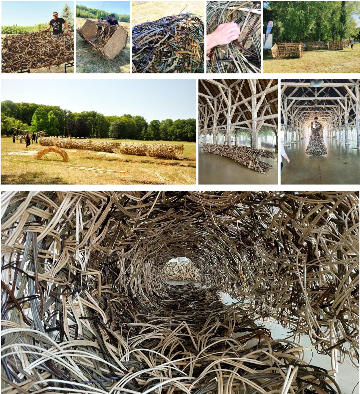
Figure 155 – Chantier de la passerelle en osier des Utopies Constructives.
