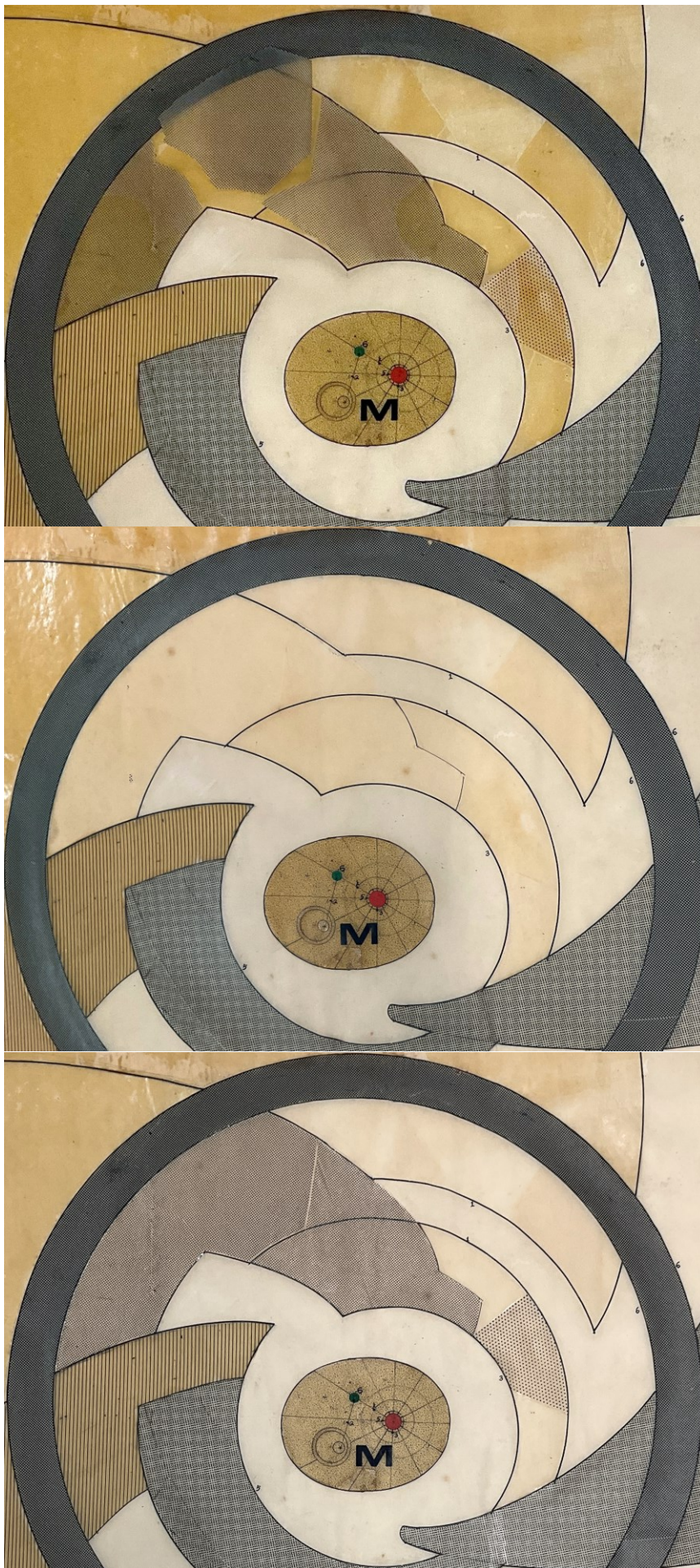
Figure 267 : Zone centrale avant, pendant et après intervention.
