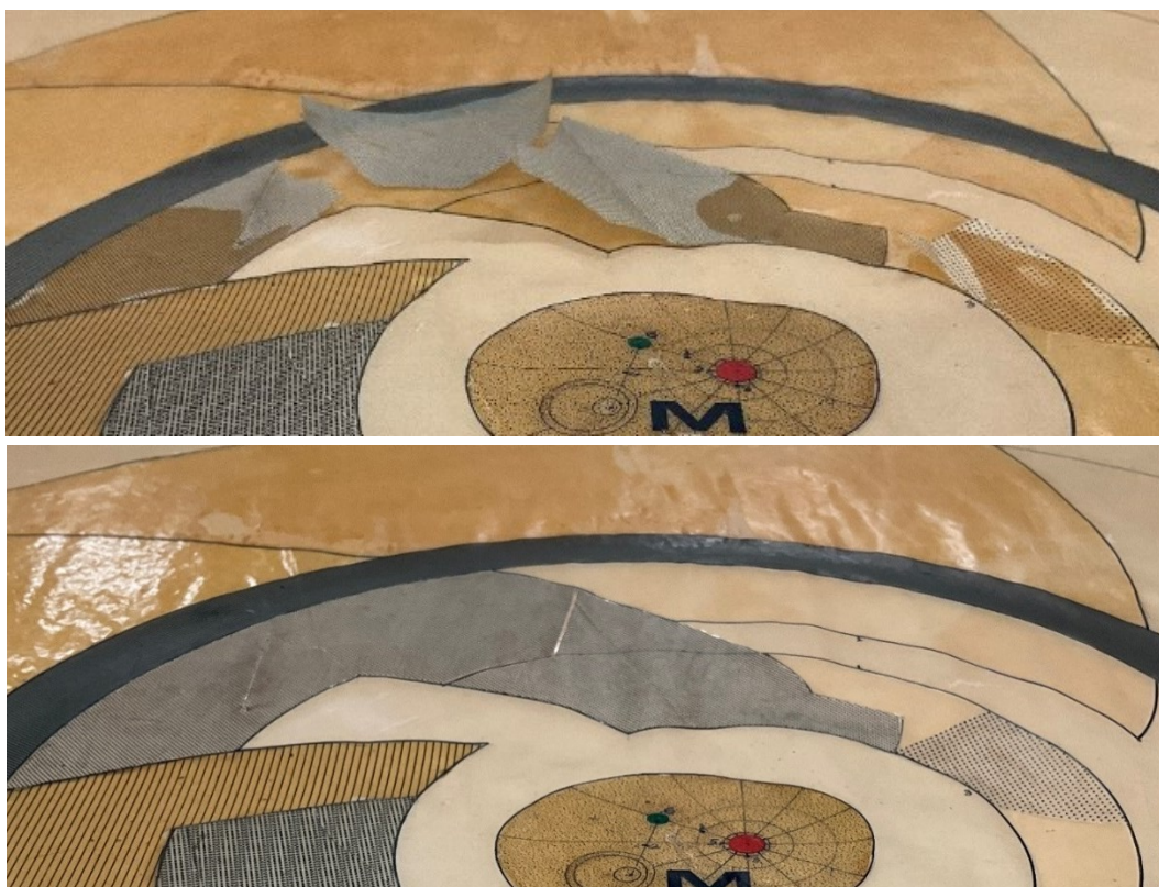
Figure 266 : Détail de la zone traitée avant et après intervention, vue en plongée.
