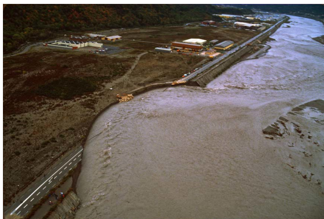
Figure 25. Photo de la digue emportée par la crue de 1982
