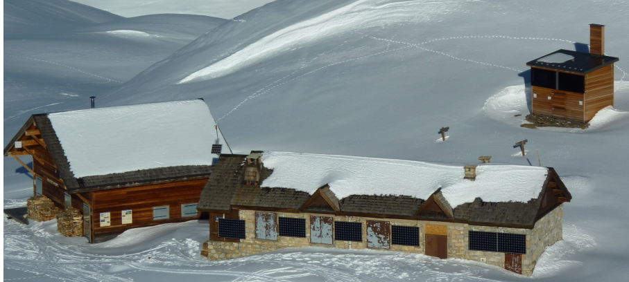
FIGURE 5 – Refuge du Col du Palet (Parc de la Vanoise), site isolé. Vue sur le refuge, les panneaux solaires verticaux (en bas) et le local hydrogène (à droite en haut)
