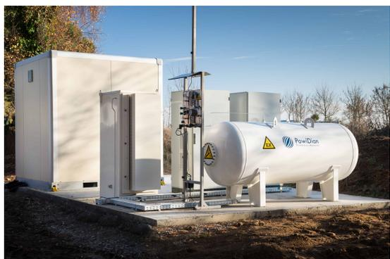
(a) Stockage hydrogène 5 kg à 30 bars
