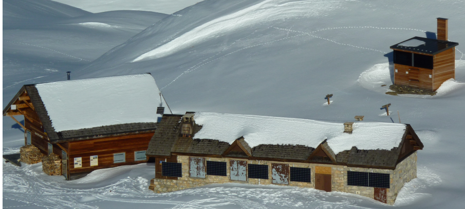
FIGURE 5 – Refuge du Col du Palet (Parc de la Vanoise), site isolé. Vue sur le refuge, les panneaux solaires verticaux (en bas) et le local hydrogène (à droite en haut)
