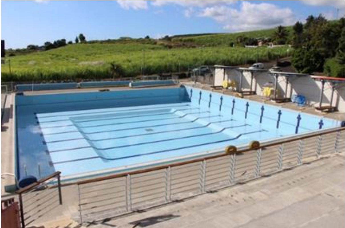
Figure 22 : Photo du grand bassin (bassin sportif) du site de Vue Belle (Saint Paul)
