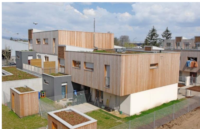
Figure 37 : Des duplex avec des toitures végétalisées dans l'écoquartier Wagner
