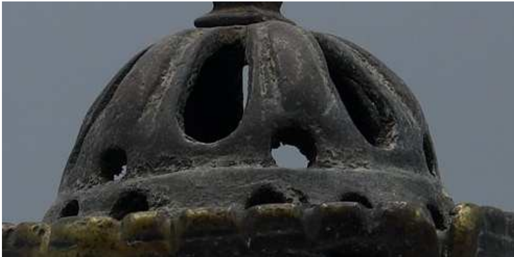
Figure 6 – Détail du niveau de couverture.
