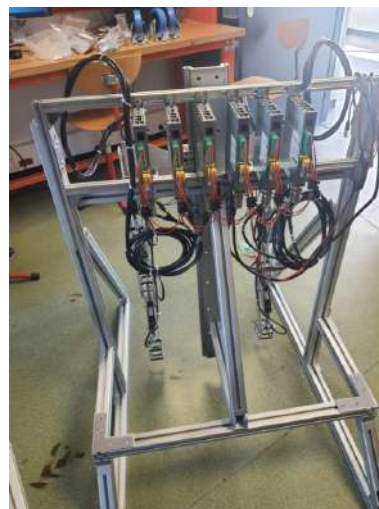
(b) Les variateurs des moteurs montés sur le portique.
