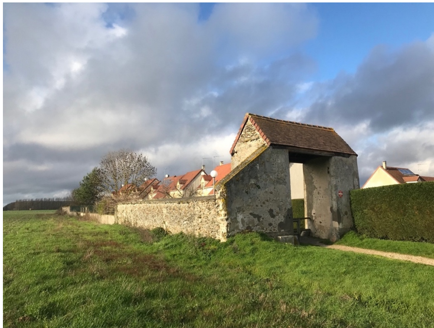
Figure 21. Le portail et les murs de la ferme du Roseau des Bourgeois, Le Perray. Le site atteste d'une architecture partagée entre les sites du mérinos mais aussi des grandes métamorphoses de la région : la cour de la ferme a été détruite pour accueillir une résidence pavillonnaire, ce qui participe de l'effacement de cette part d'histoire agricole du territoire. Les Bourgeois possédait la plus grande partie des terres à l'Ouest du Perray jusqu'aux Bréviaires voisines au XIX e siècle. Photographie de l'auteur, 17 décembre 2020.
