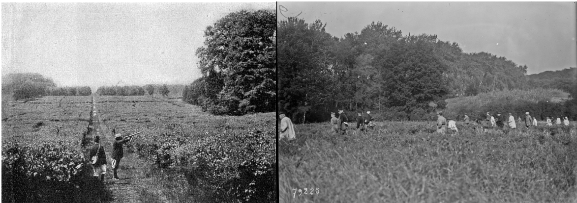
Figure 63. À gauche : LEDDET, 1912, p. 309. La photographie donne à voir des tirés extrêmement denses, où l'on discerne à peine les layons secondaires. Seul le layon central qui permet l'agrainage des faisans permet le passage d'un chasseur. À droite : la ligne de rabat lors de la chasse diplomatique du 25 octobre 1922 à Rambouillet, photographie de l'Agence Roll, BNF, département Estampes et photographie, EI-13 (952).
