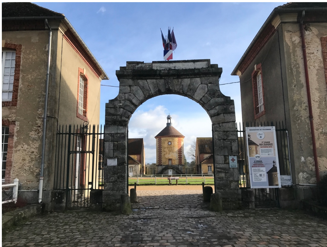
Figure 85. Une vue contemporaine du portail et du colombier de la Bergerie nationale. Photographie de l'auteur, 22 janvier 2021.
