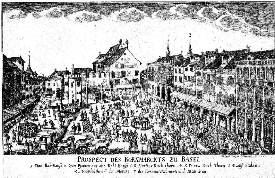
Illustration n°26 Jakob Meyer, Prospect des Kornmarkts zu Basel, (StaABS, BILD 2,592). La maison Zscheckenbürlin occupe le fond de la place du Marché
