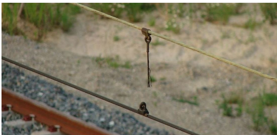
FIGURE 3.13 – Pendule d'une caténaire cassé.
