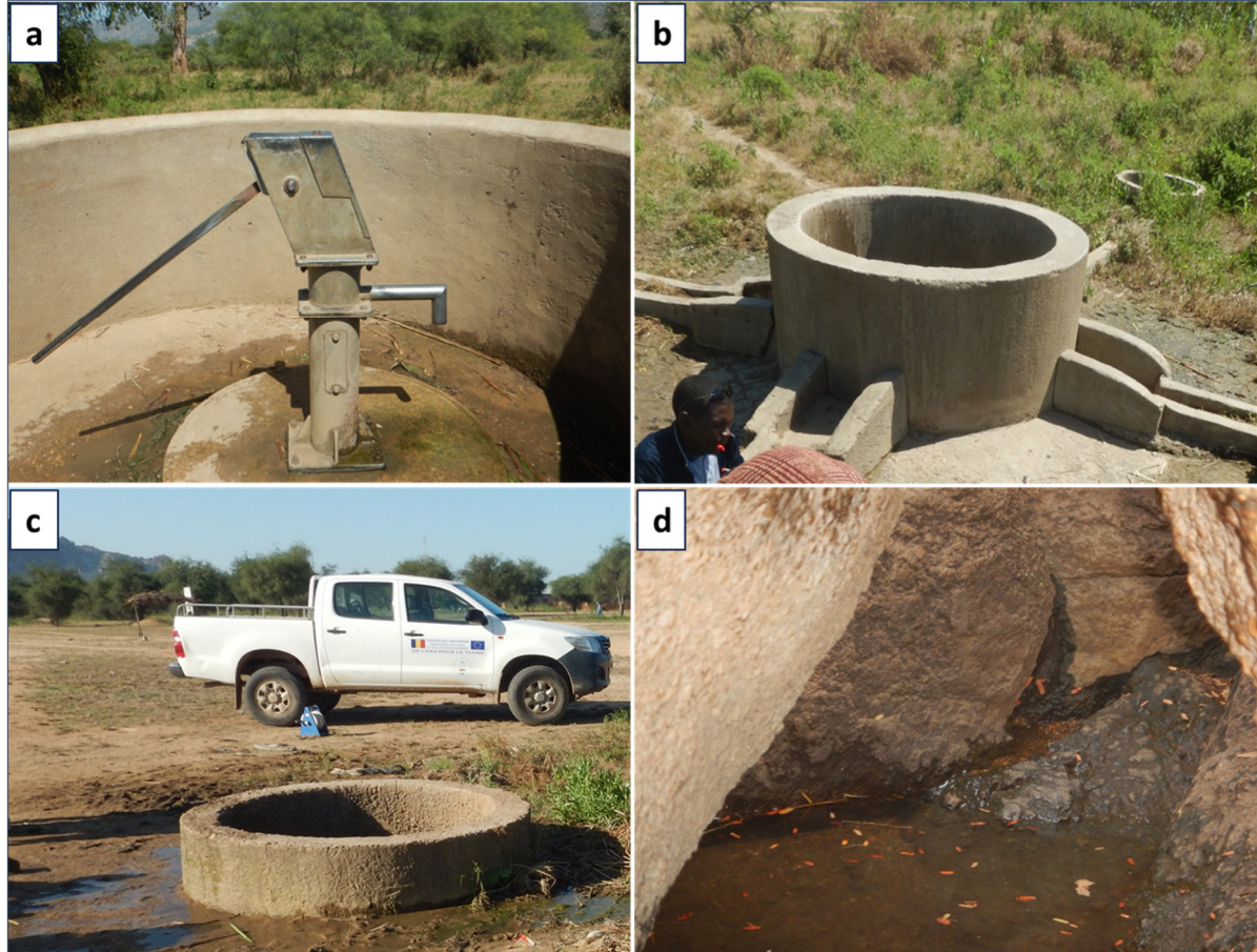
Figure III.37 : Différents types d'ouvrages mesurés : Forage (F) profond à pompe à motricité humaine (a), Puits sur Fracture (PF) ouvert (b), puits (P) peu profonds (c) et Source (S).
