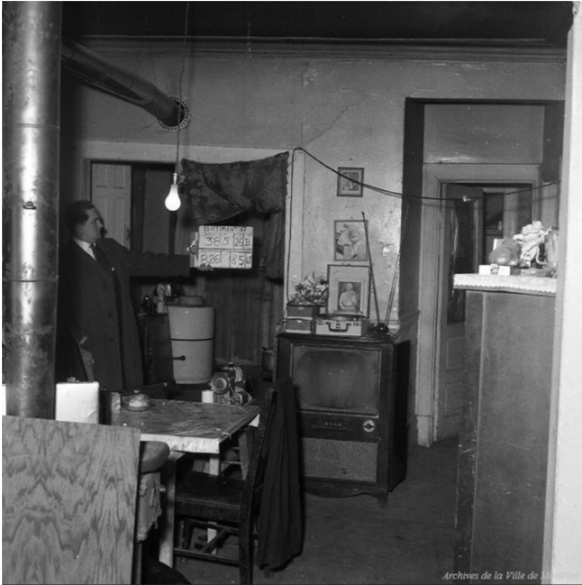
Figure 107 : Intérieur du 826 rue Saint-Martin dans le quartier de la Petite-Bourgogne avec son filage électrique hasardeux
