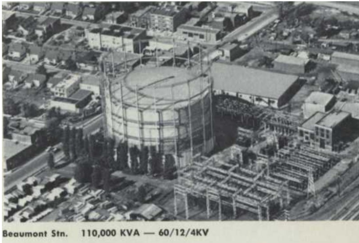
Figure 125 : Sous-station électrique et gazomètre Beaumont
