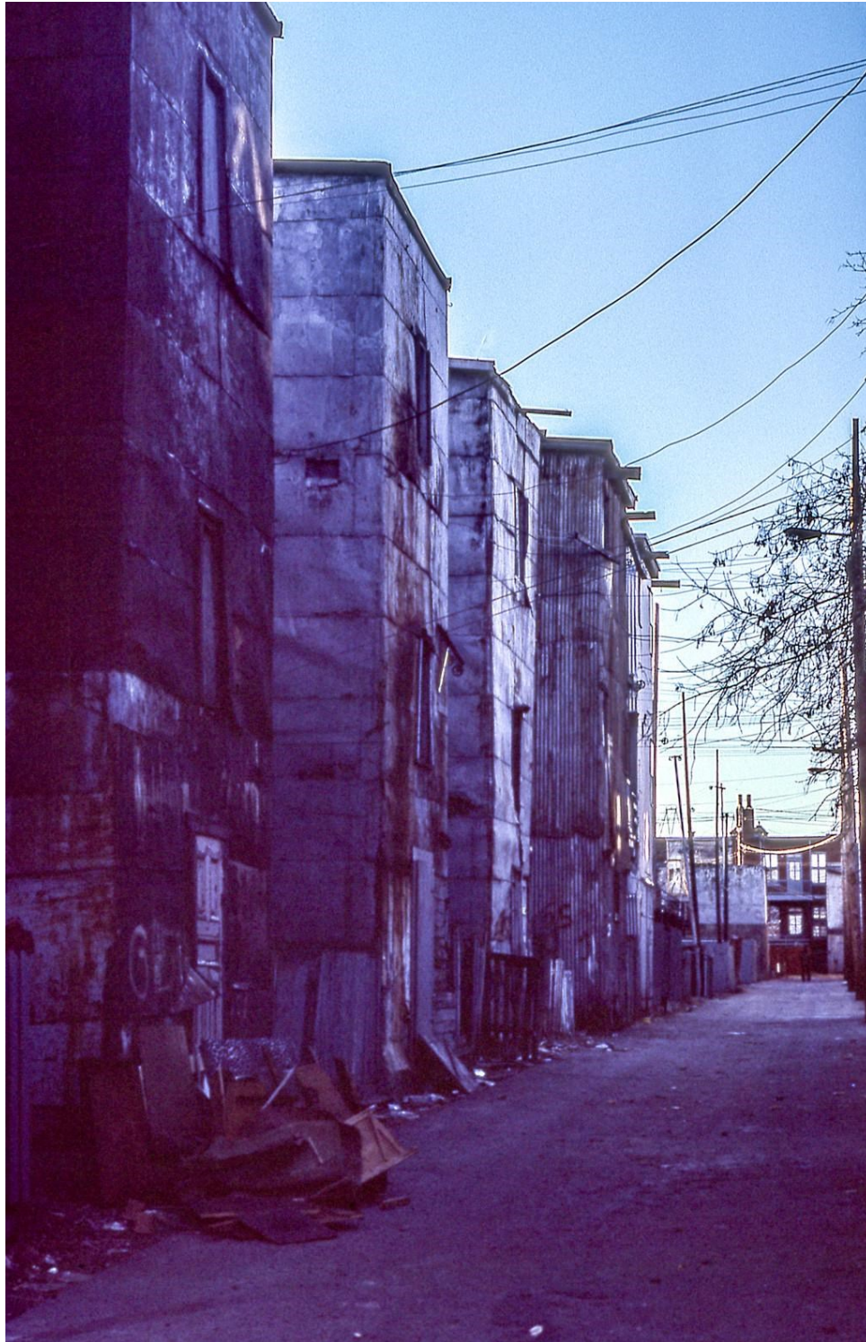
Figure 36 : Hangars situés à l'arrière des logements et accessibles par la ruelle. On y stockait notamment les combustibles divers ou encore les blocs de glace. Exemple ici entre la 1 e et la 2 e avenue et les rues Dandurand et Holt dans le quartier Rosemont On devine au sommet des hangars du fond les montants sur lesquels reposaient les poulies qui servaient à hisser les matériaux jusqu'en haut
