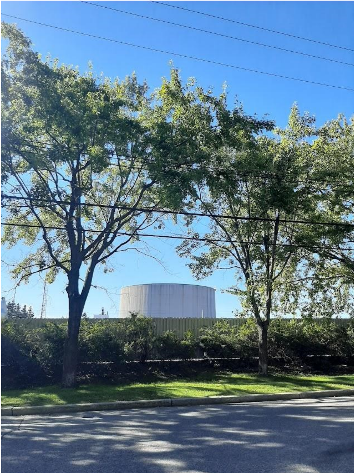
Figure 70 : Réservoir visible depuis une rue résidentielle de Montréal-Est
