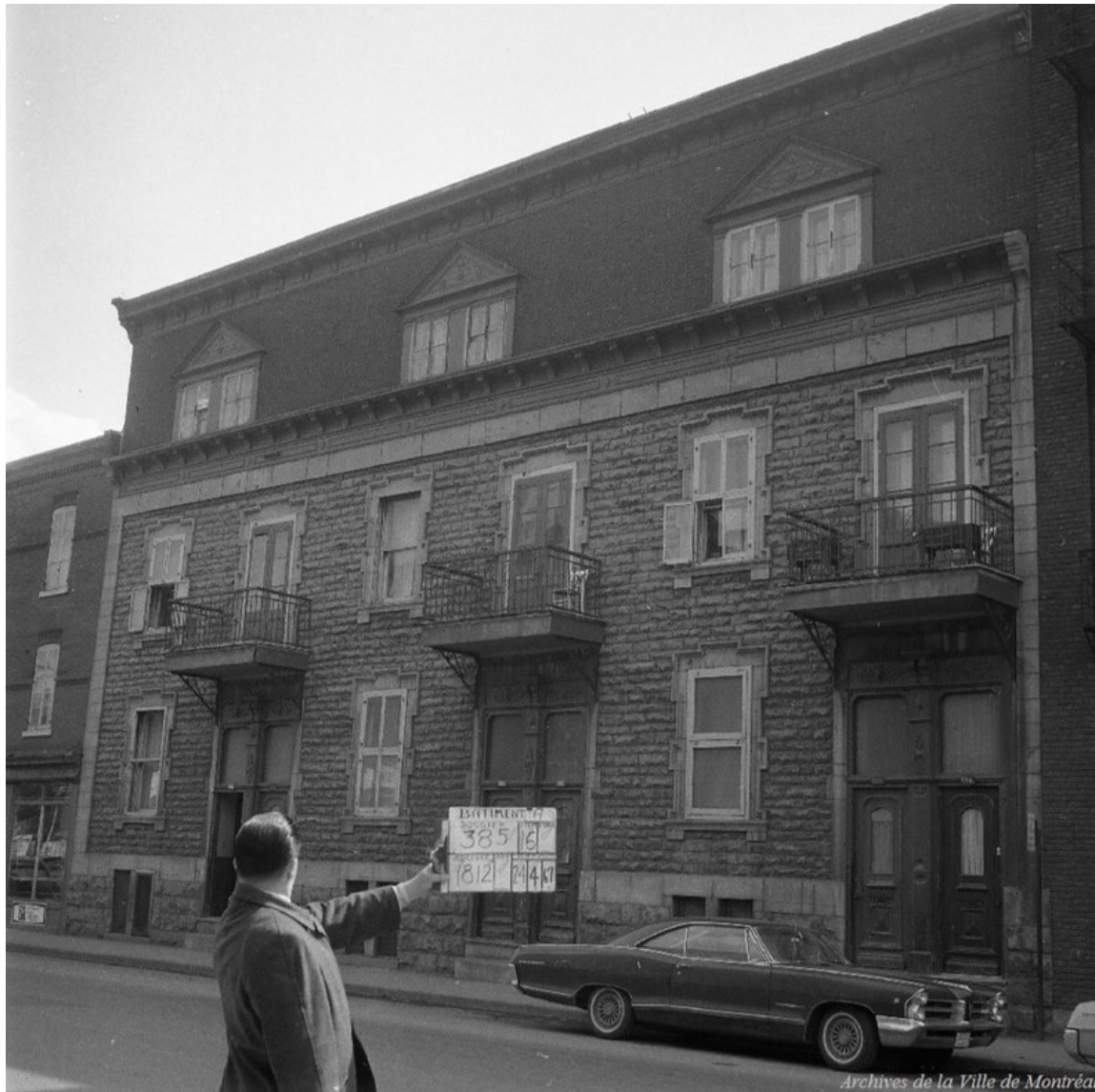
Figure 101 : Exemple de plex ouvrier sans marge de recul dans le quartier de la Petite-Bourgogne sur la rue Saint-Antoine. Cet immeuble est exproprié puis démolé dans le cadre d'une campagne de rénovation urbaine au profit de la construction de l'autoroute Ville-Marie
