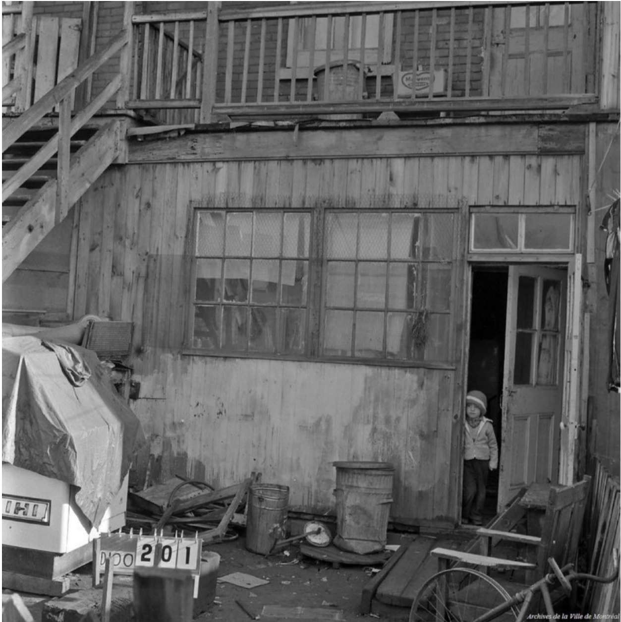
Figure 104 : Arrière-cour d'un immeuble à logements à Victoriatown (Goose Village)
