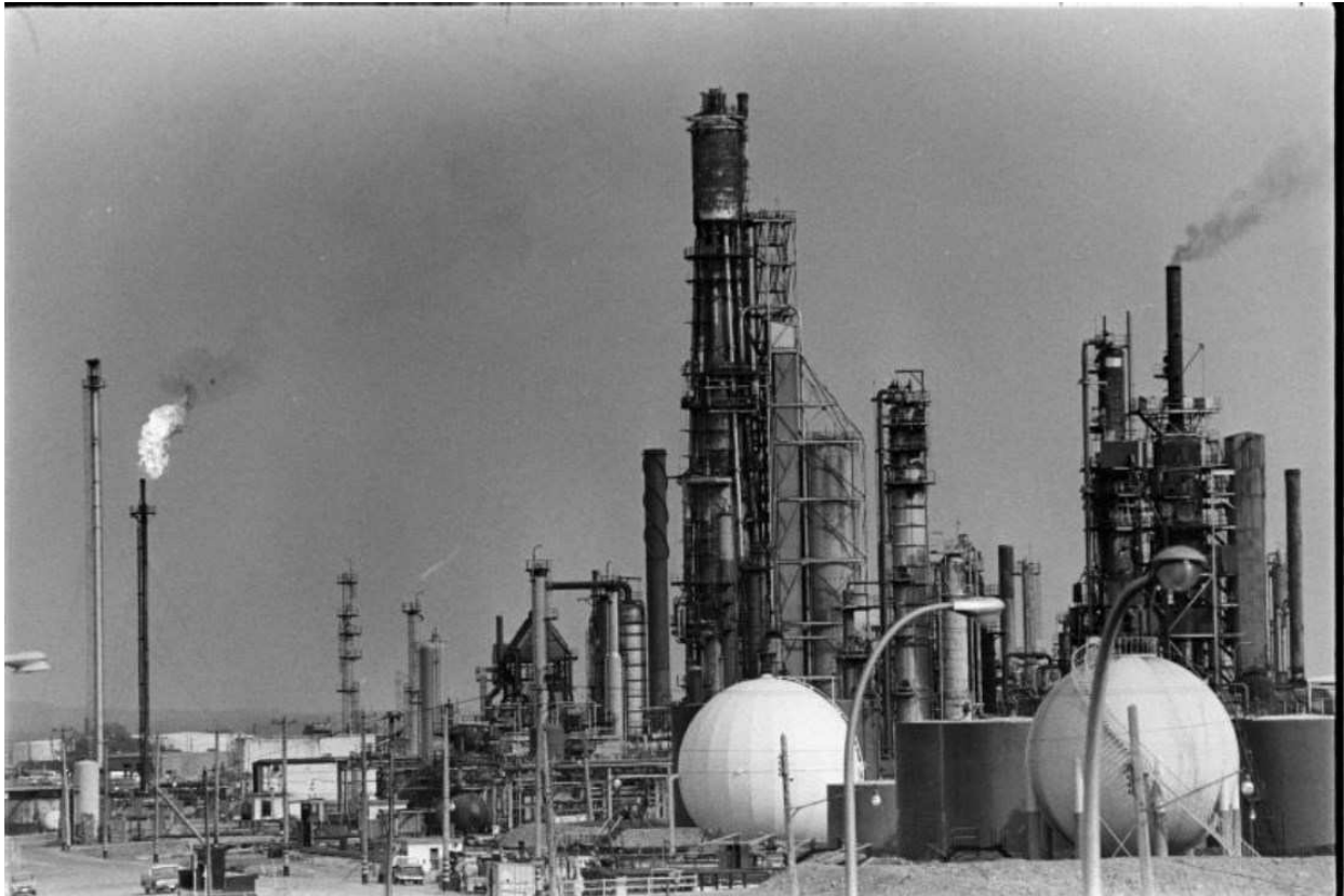
Figure 45 : Raffinerie de Petrofina. À gauche, une torchère, détectable à sa flamme au sommet, qui évacue des résidus pétroliers
