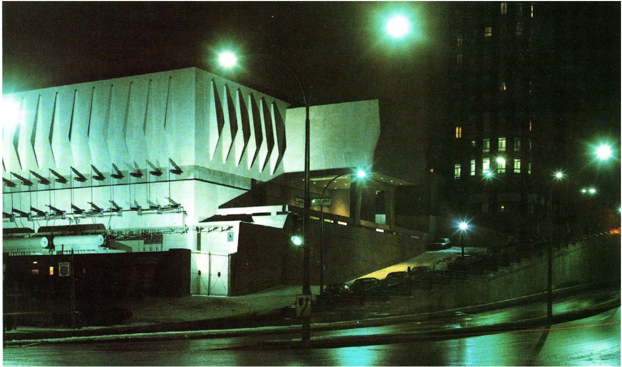
Figure 159 : Poste de distribution Berri d'Hydro-Québec
