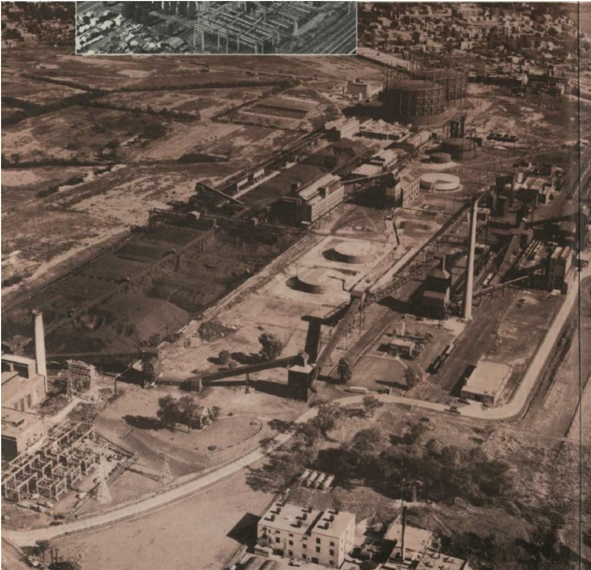
Figure 128 : Sous-station électrique, usine à gaz et gazomètres de LaSalle
