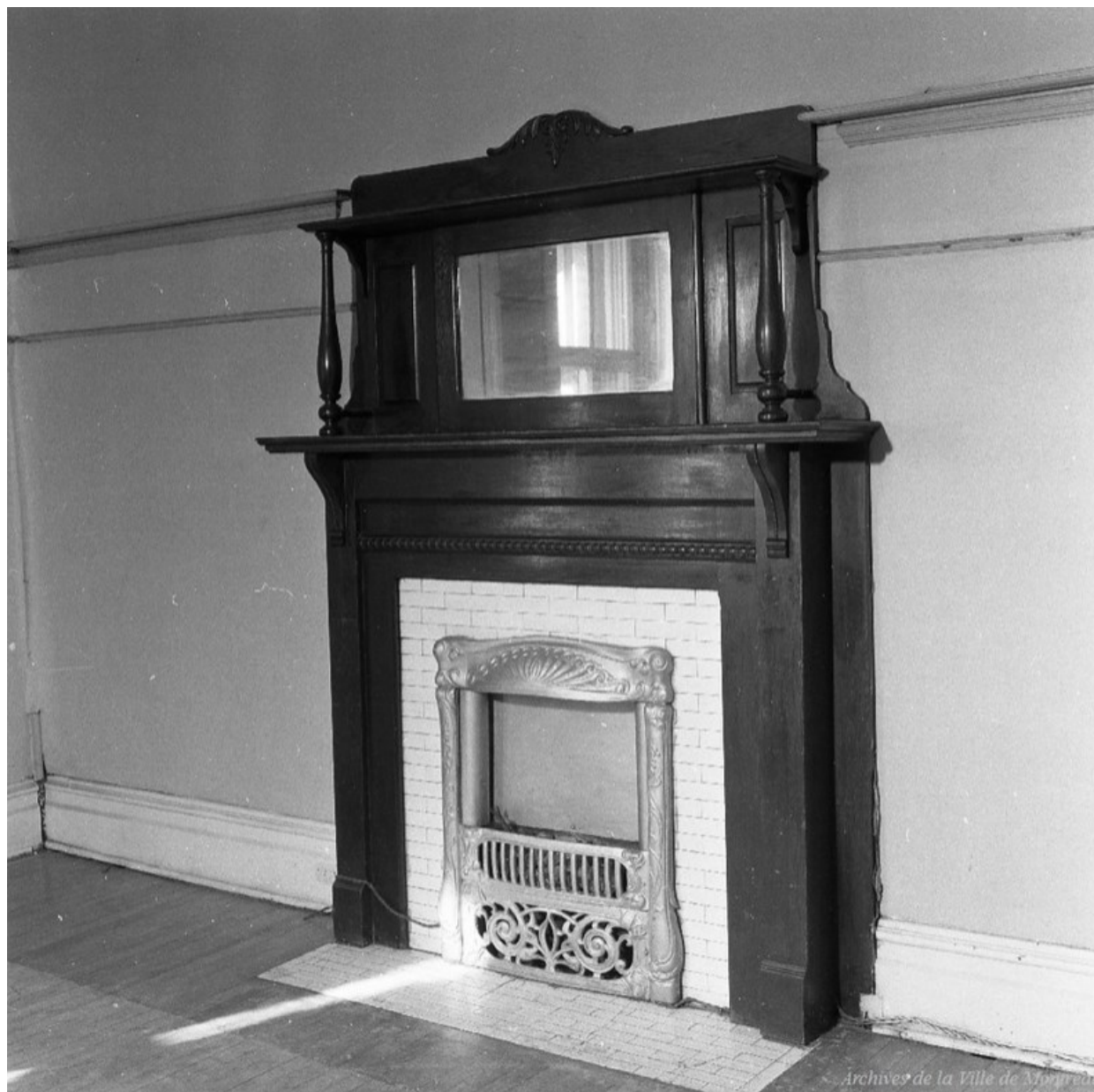
Figure 116 : Foyer dans un immeuble résidentiel du secteur de la Place-des-Arts avant sa démolition
