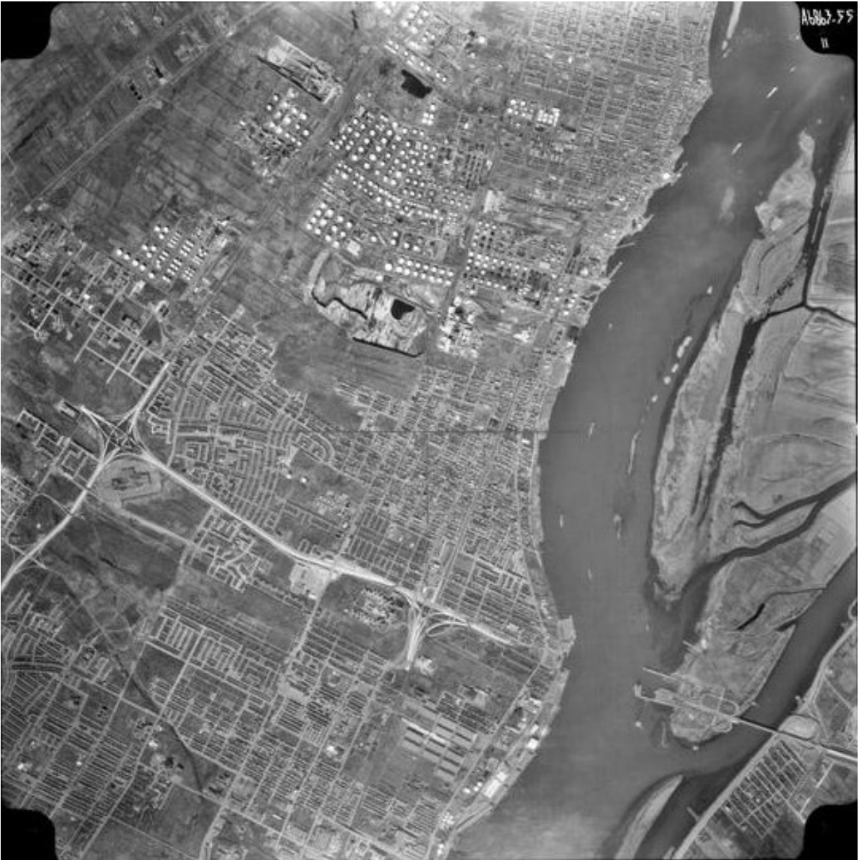
Figure 49 : Photographie aérienne de 1968 qui montre une grande partie de l'est de l'île de Montréal. On y voit le pont-tunnel Louis-Hippolyte-La Fontaine en construction (en bas à droite), l'échangeur cruciforme entre les autoroutes 25 et métropolitaine au centre à gauche, la raffinerie de British Petroleum au nord-est de cet échangeur ainsi que les autres raffineries de Montréal-Est et de Pointe-aux-Trembles
