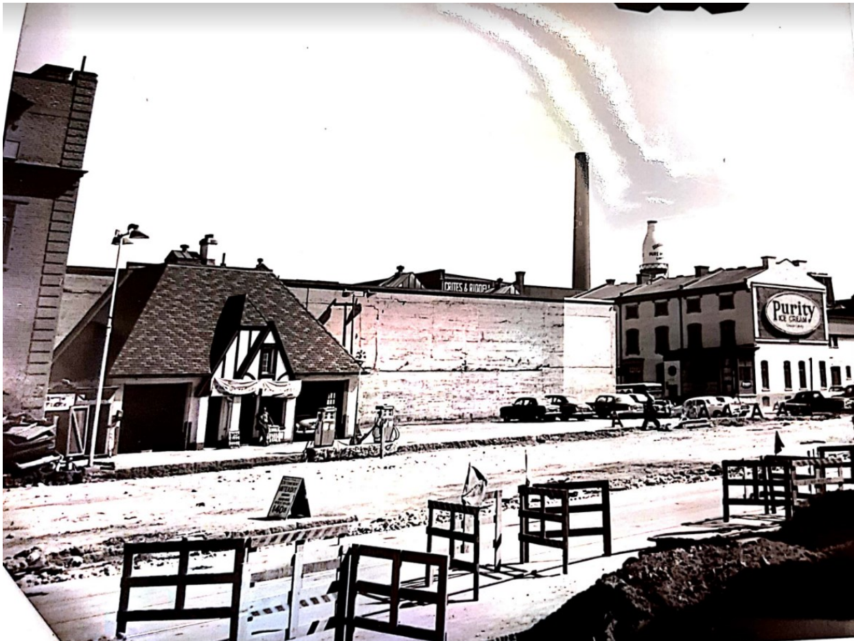
Figure 26 : Poste d'essence de style romantique de la compagnie Petrofina situé à l'angle du boulevard Dorchester (aujourd'hui René-Lévesque) et de la rue de la Montagne
