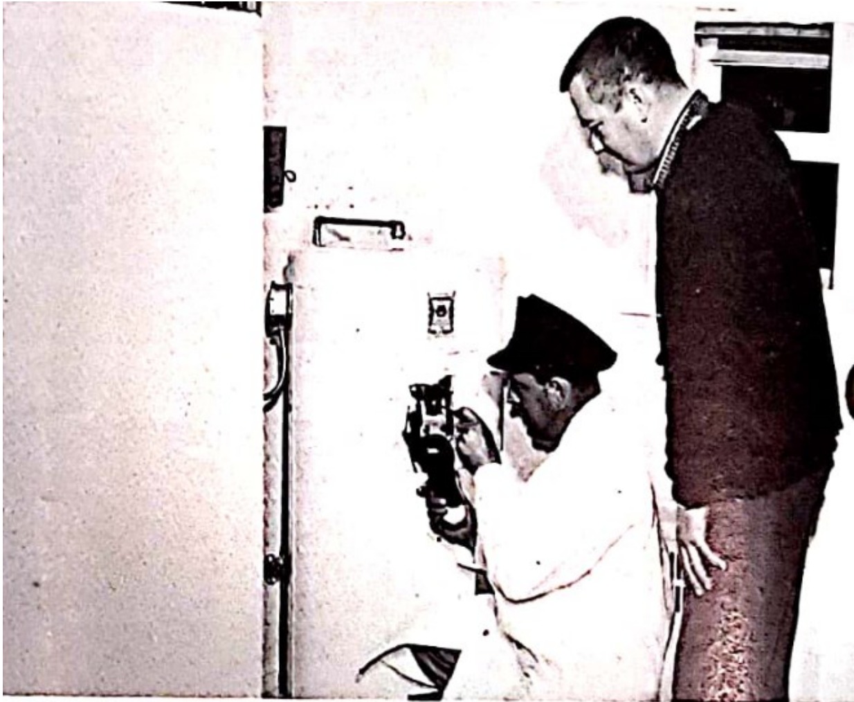
Figure 134 : Un inspecteur d'Hydro-Québec vérifie l'installation d'un chauffe-eau électrique chez un abonné
