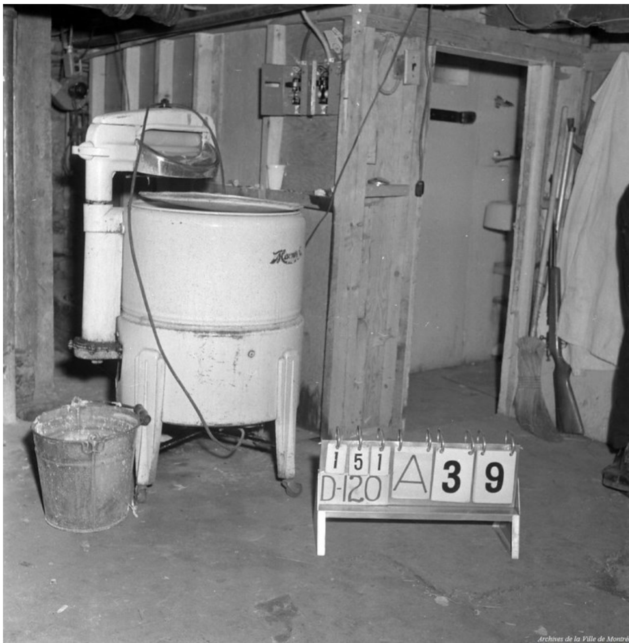
Figure 109 : Sous-sol d'un immeuble à logements avec machine à laver manuelle de type lessiveuse, secteur de l'autoroute Ville-Marie
