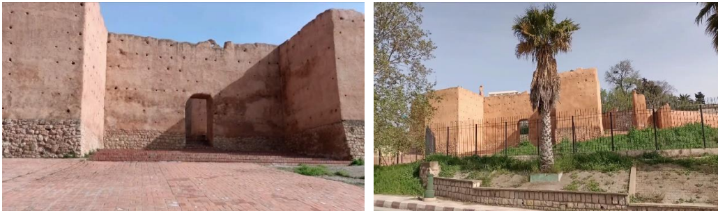
Figure 48 Vue extérieure du site Bâb El Kermâdîne
