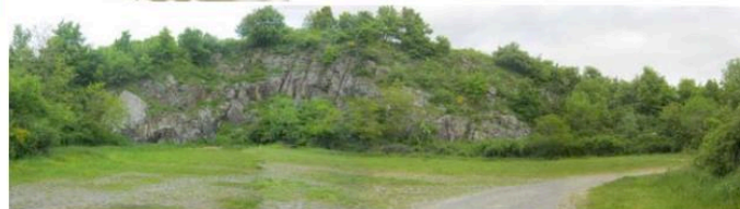
La carrière et le belvédère: état existant
