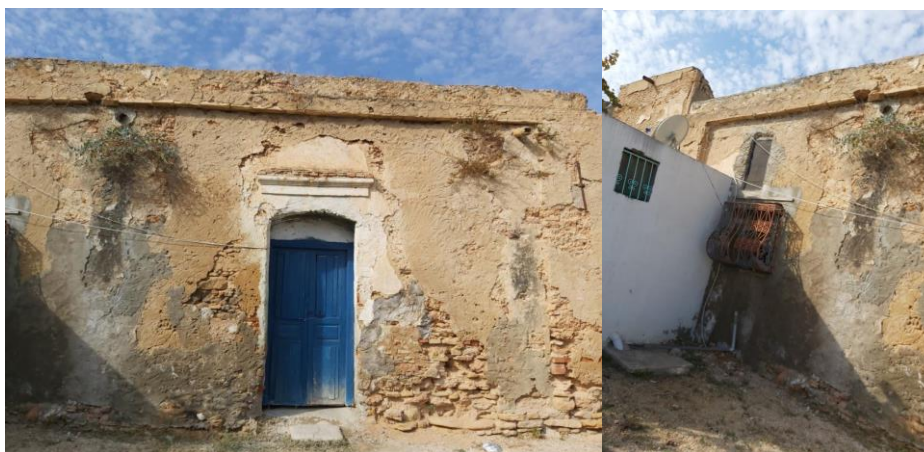
Figure 83. Chambre occupée par les deux frères. (Source : Hamrouni, 2020)
