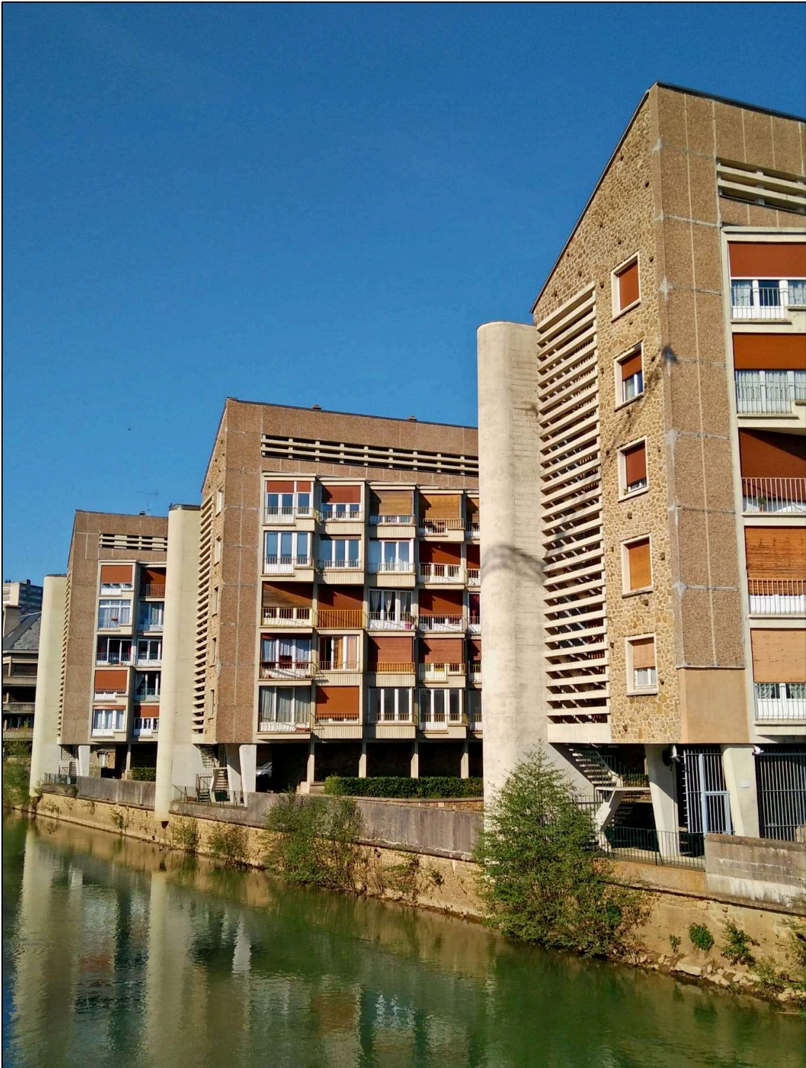
Figure 6. Immeubles de la Reconstruction en bord de Meuse, Sedan, 2018.
