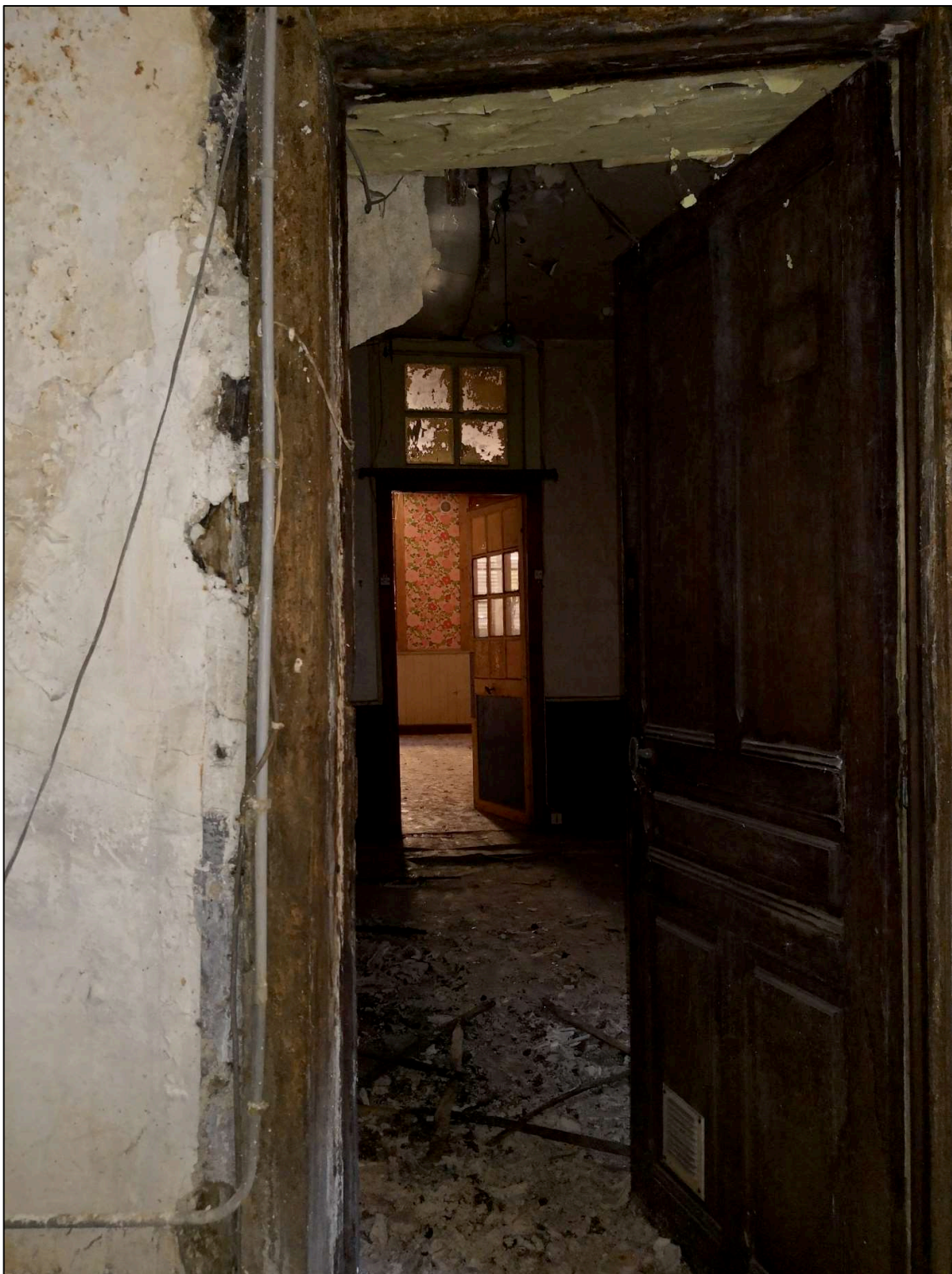
Figure 5. Couloir dans un immeuble abandonné, Tulle, 2019.
