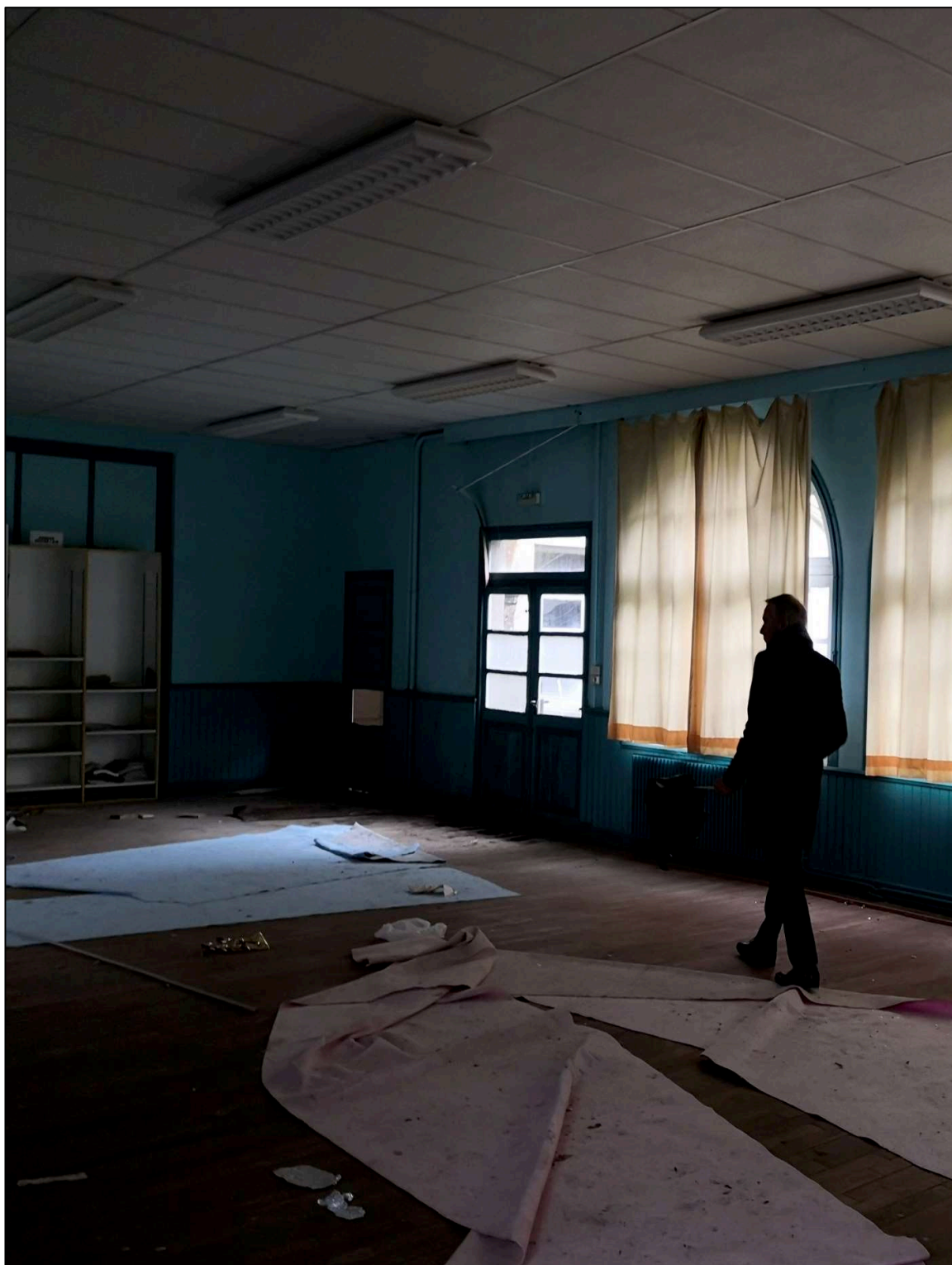
Figure 38. Visite de site d'un collège désaffecté, Tulle, 2019.
