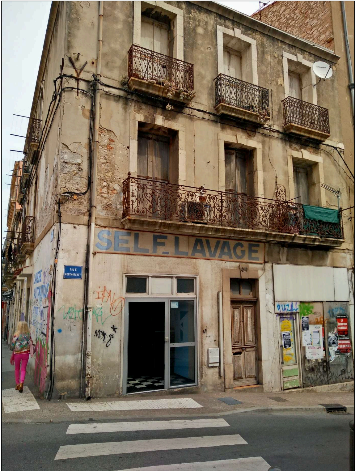
Figure 2. Vue de la façade d'un immeuble, Sète, 2018.
