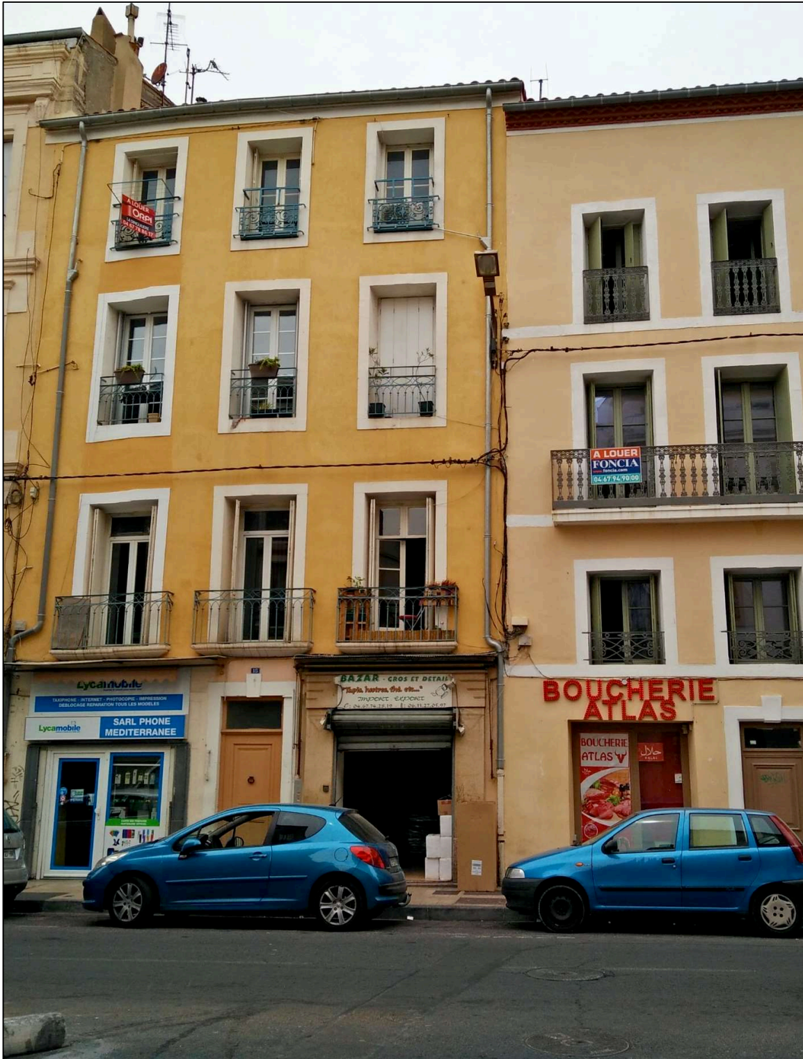
Figure 15. Immeubles avec des appartements proposés à la location, Sète, 2018.
