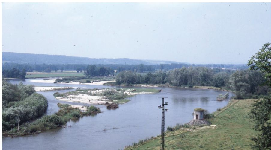
FIGURE 2.19 : Station de pompage de Virecourt (Photographie M. et Mme Tacail)
