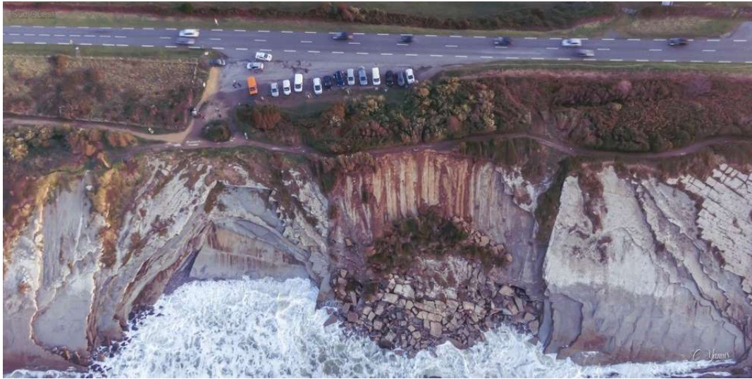
FIGURE 5.1 – Effondrement d’un pan de falaise à Urrugne (Pyrénées-Atlantiques) après le passage de la vague Belharra le 29/10/2020.
