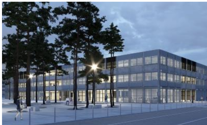
Figure 5. 38 Simulation de la Halle de l'innovation, « La halle de l'innovation sort de terre à Cambacères », Montpellier3m , 26 décembre 2019 (en ligne, consulté le 10 juillet 2023), https://www.montpellier3m.fr/actualite/la-halle-de-linnovation-sort-de-terre-cambaceres
