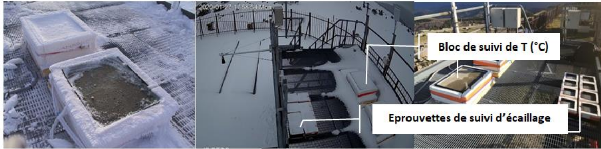
Figure 4-12 : Photos des éprouvettes de béton du suivi d'écaillage et des blocs de suivi de température.
