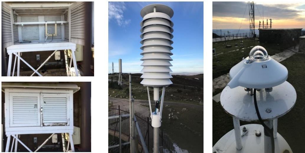
Figure 4-3: De gauche à droite Boîtier Stevenson à double étagère en orientation opposée, anémomètre ultrasonique, pyranomètre CMP6 de Kipp&Zonen pour mesure du rayonnement solaire (direct et diffus).
