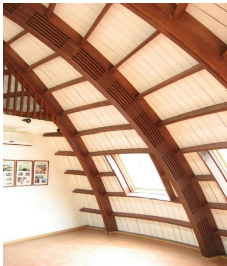
Salle de réunion de la réserve Loango : Structure de coupole en bois lamellé collé et éléments ossature bois préfabriqués. Année de réalisation : 2007 - délai de réalisation, 4 mois.
