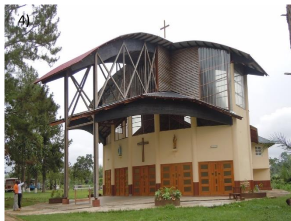
(3) Amphi USTM : Structure bois sur couverture en dur. Année de réalisation : 2010 - délai de réalisation, 6 mois. (4) Église Okondja : Structure bois et couverture sur construction en dur. Année de réalisation : 2007/ 2008 - délai de réalisation, 6 mois.
