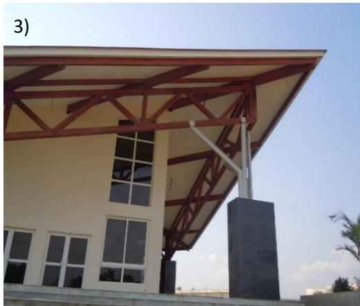
(3) Amphi USTM : Structure bois sur couverture en dur. Année de réalisation : 2010 - délai de réalisation, 6 mois. (4) Église Okondja : Structure bois et couverture sur construction en dur. Année de réalisation : 2007/ 2008 - délai de réalisation, 6 mois.
