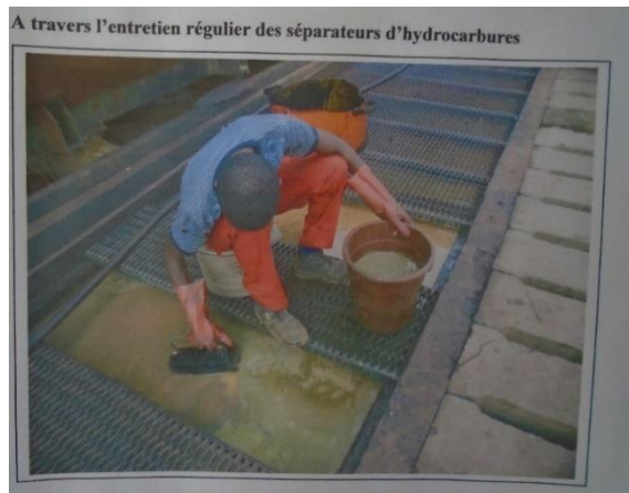
1- À travers l'entretien régulier des séparateurs d'hydrocarbures
