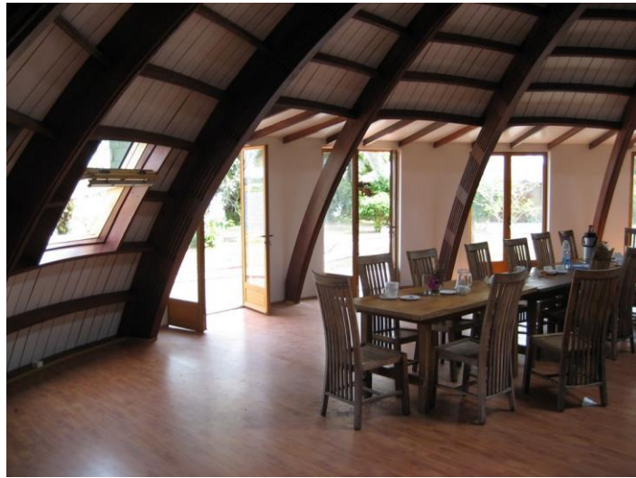
Salle de réunion de la réserve Loango : Structure de coupole en bois lamellé collé et éléments ossature bois préfabriqués. Année de réalisation : 2007 - délai de réalisation, 4 mois.
