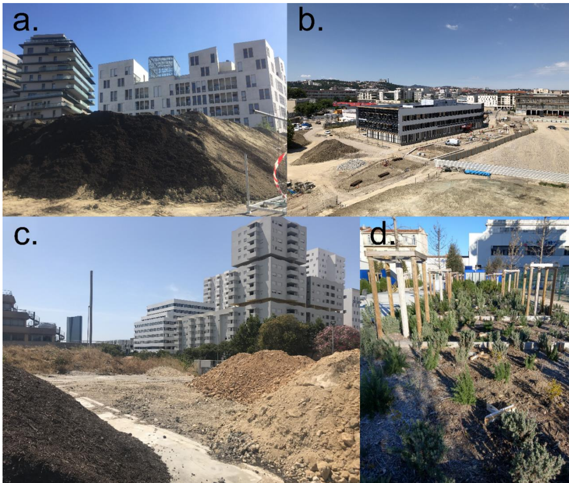
Figure 4 : a., b., mise en andain des sols destinés aux fosses de plantations à Lyon, France, c. sol récemment descellé dans le quartier des Fabriques, Marseille, et d. Végétalisation du sol récemment descellé dans les fosses de plantation expérimentales du quartier des Fabriques, Marseille, France
