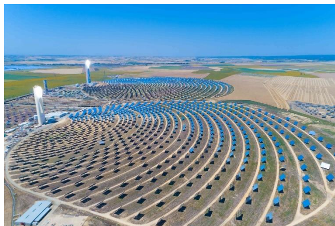
Figure I-41 : Photo des tours solaires SP10 et SO20 à Séville en Espagne.
