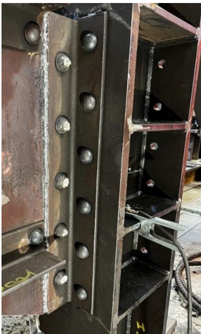
a). Côté gauche de l'assemblage
