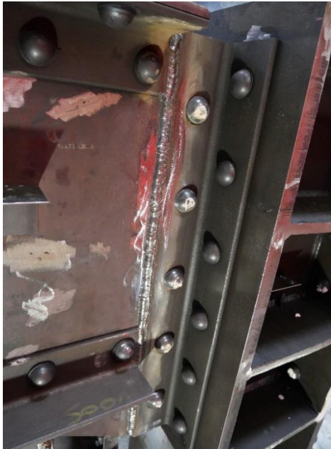
a). Partie gauche de l'assemblage (3 passes)
