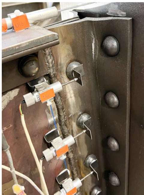
e) Arrachement de la cornière d'AR-S-1
