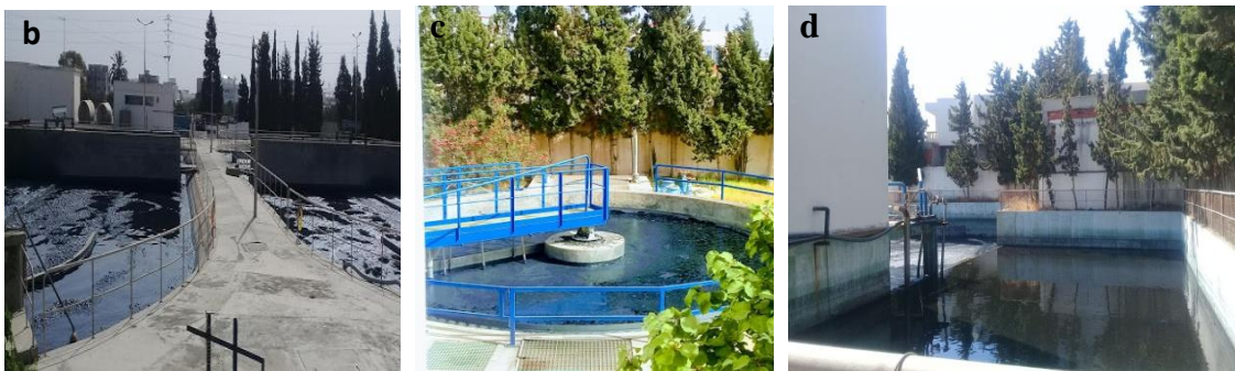
Figure 2.3: Unité de traitement des eaux usées de l'industrie SITEX. a- plan de l'unité de traitement des eaux usées ; b- chenal d'oxydation ; c- décanteur et d- bassins d'eau traitée (traitement biologique secondaire) (Photos : SITEX, 2019).
