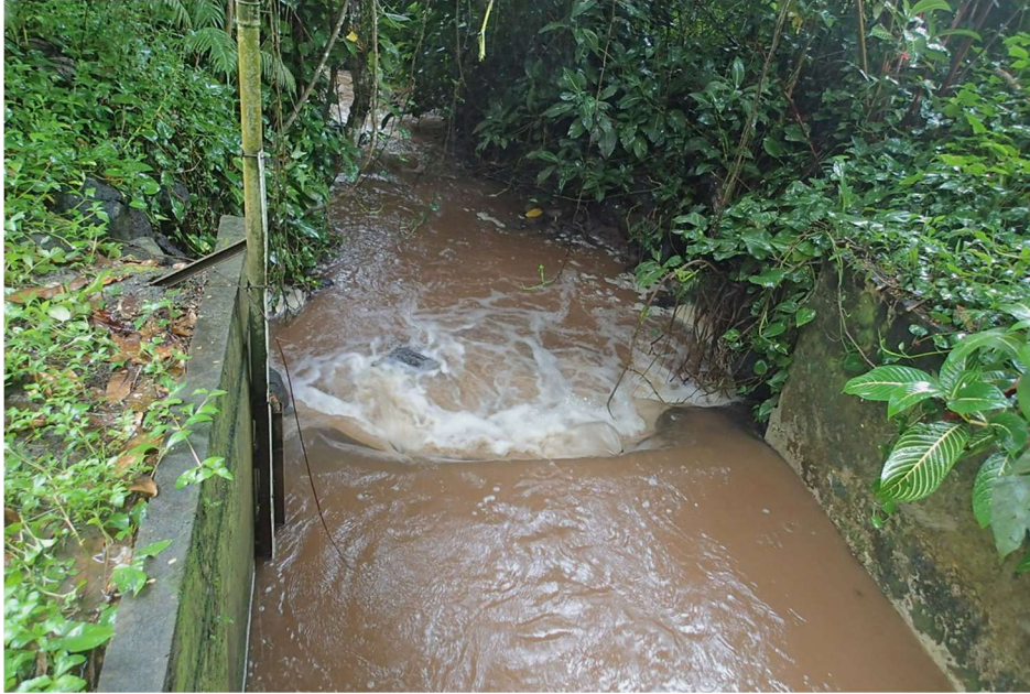
Figure B-10 : Station limnimétrique Vaipahi C05 (photo GEGDP).
