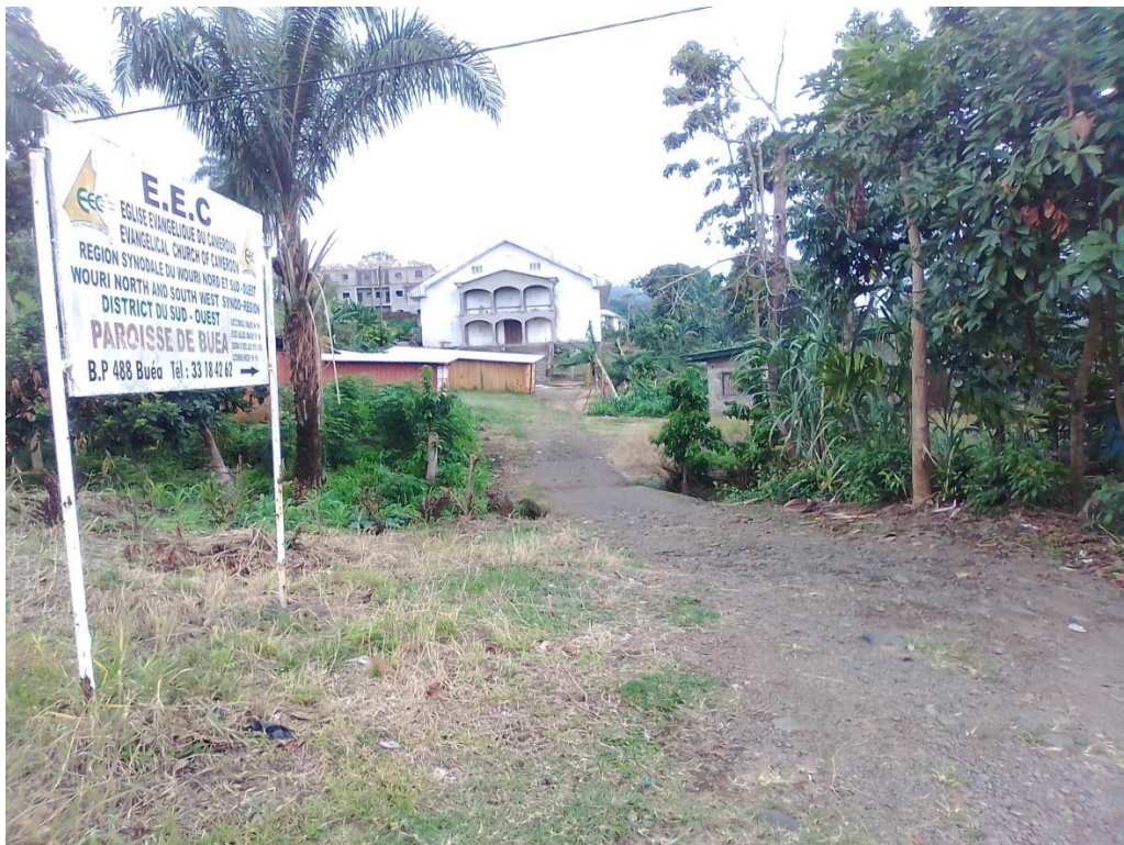
Photo n°3 – Église Évangélique du Cameroun, 07 avril 2019 (MNN)
