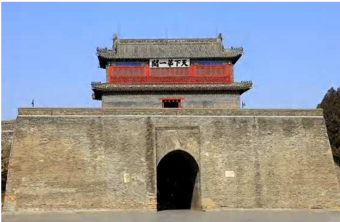
Figure 3 : La passe Shanhaiguan en tant que site touristique. Nous remarquons la calligraphie d'en haut portant le titre « la première passe sous le ciel »
