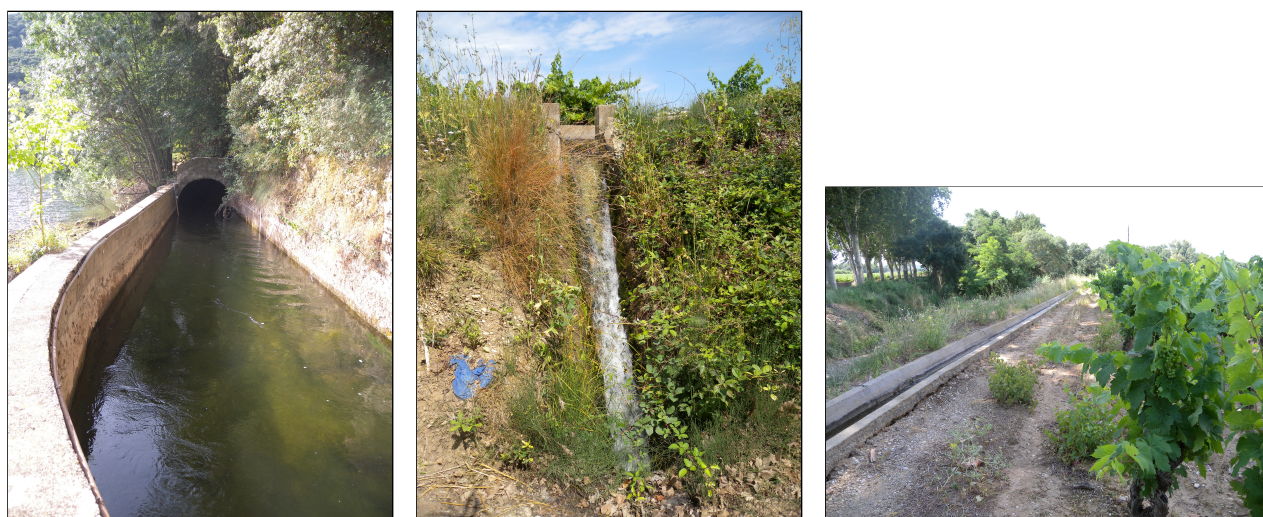
(a) Canal rive droite après le répartiteur à Saint-Guilhem-le-Désert, juin 2012. (b) Retour de l'eau dérivée au réseau hydrographique à Pouzols, juillet 2012. (c) Goulotte dans un champ de vigne à Pouzols, juillet 2012.
